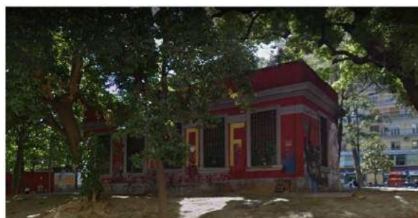
EDIFICIO ESISTENTE DA RIQUALIFICARE
