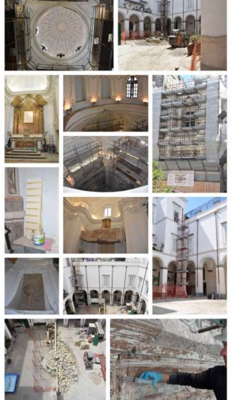
IMMAGINI DEL CANTIERE IN CORSO D'OPERA
