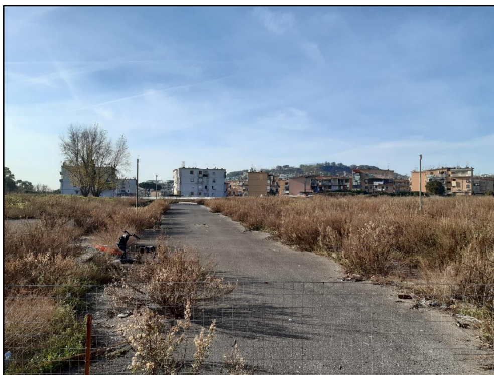
Fig. 5. Soccavo: veduta del lotto di pertinenza del secondo intervento destinato a verde pubblico e parcheggio (sub-ambito 2 del PRU di Soccavo).
