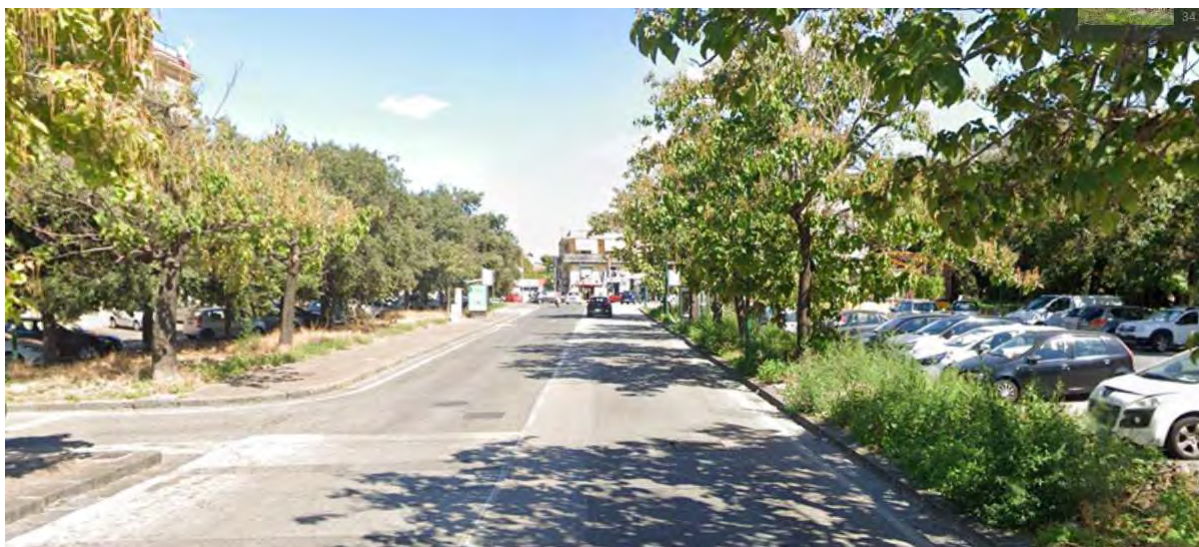
Figura 48 - Stato di fatto
