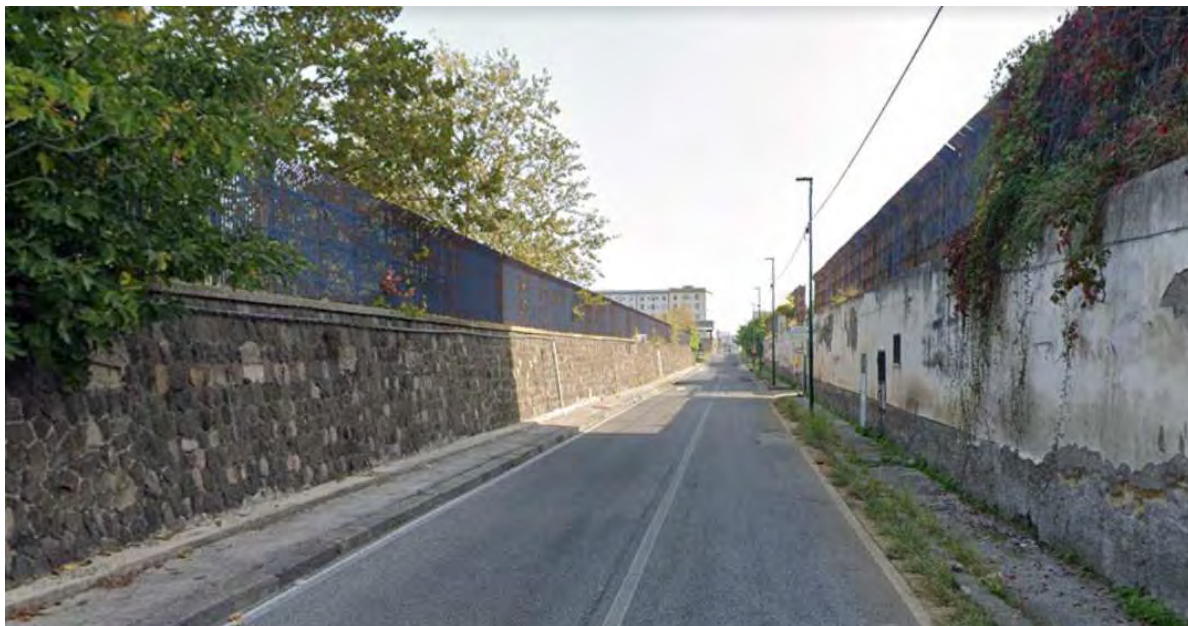
Figura 42 – Stato di fatto
