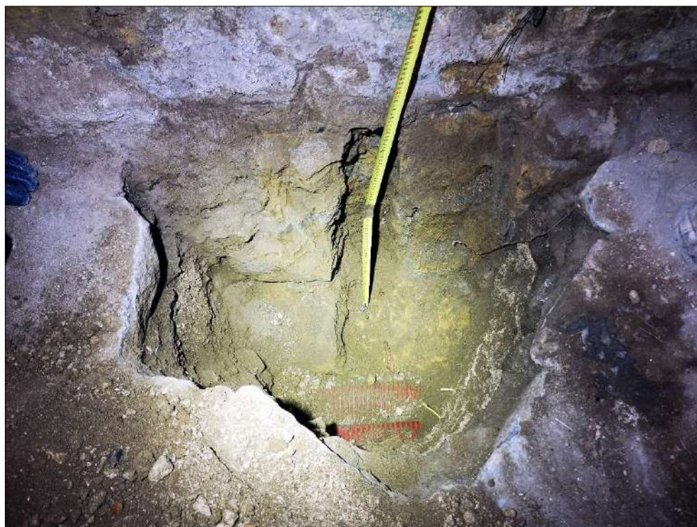
Foto 3: Particolare dello scavo.
