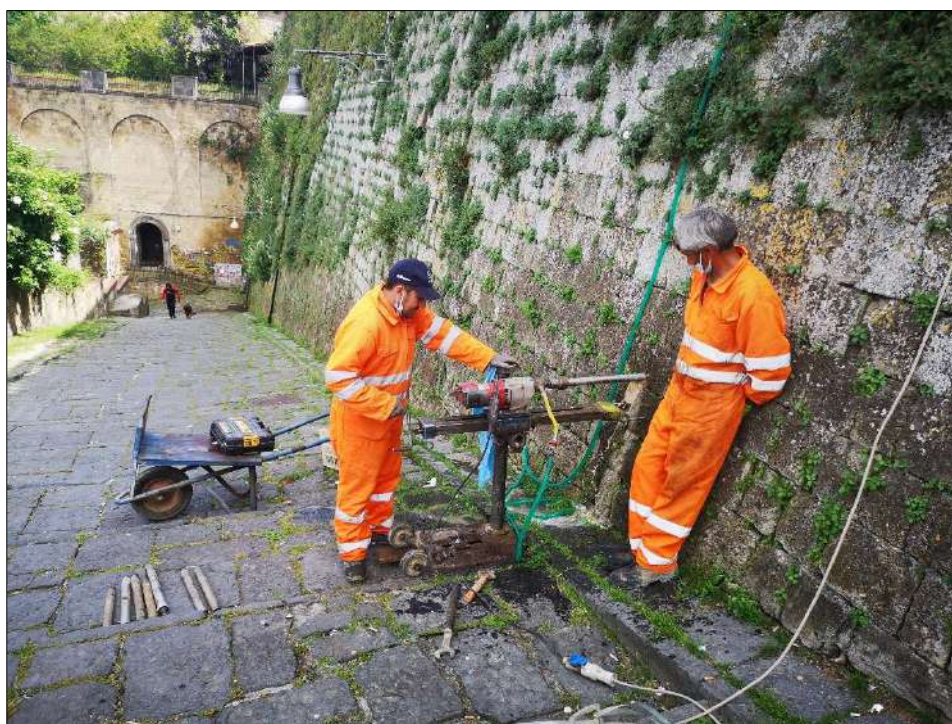
Foto 7: Micro carotaggio n° 2 nella parte alta della prima rampa della scala.
