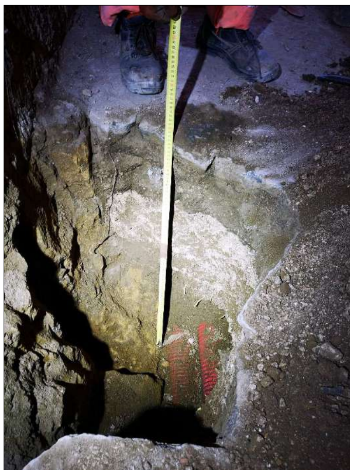
Foto 4: Particolare dello scavo- vista verso monte.
