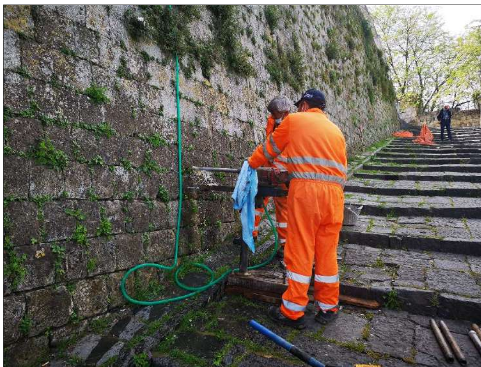
Foto 6: Micro carotaggio n° 2 nella parte alta della prima rampa della scala.
