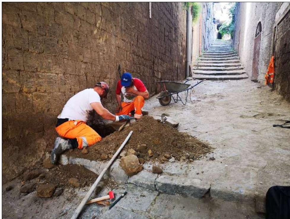
Foto 2: Panoramica area in cui è stato realizzato lo scavo.
