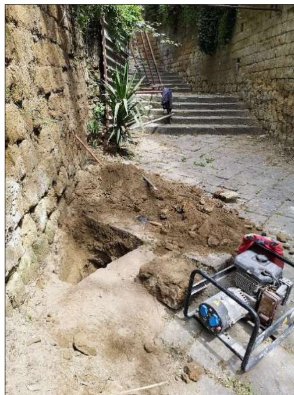
Foto 2: Scavo n° 1 realizzato in prossimità del muro crollato.
