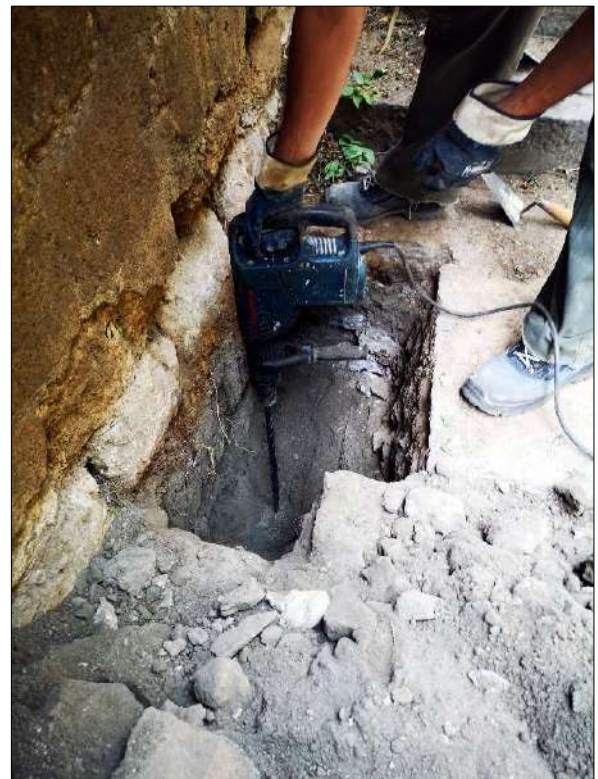
Foto 8: Scavo n° 2 ultimato.
