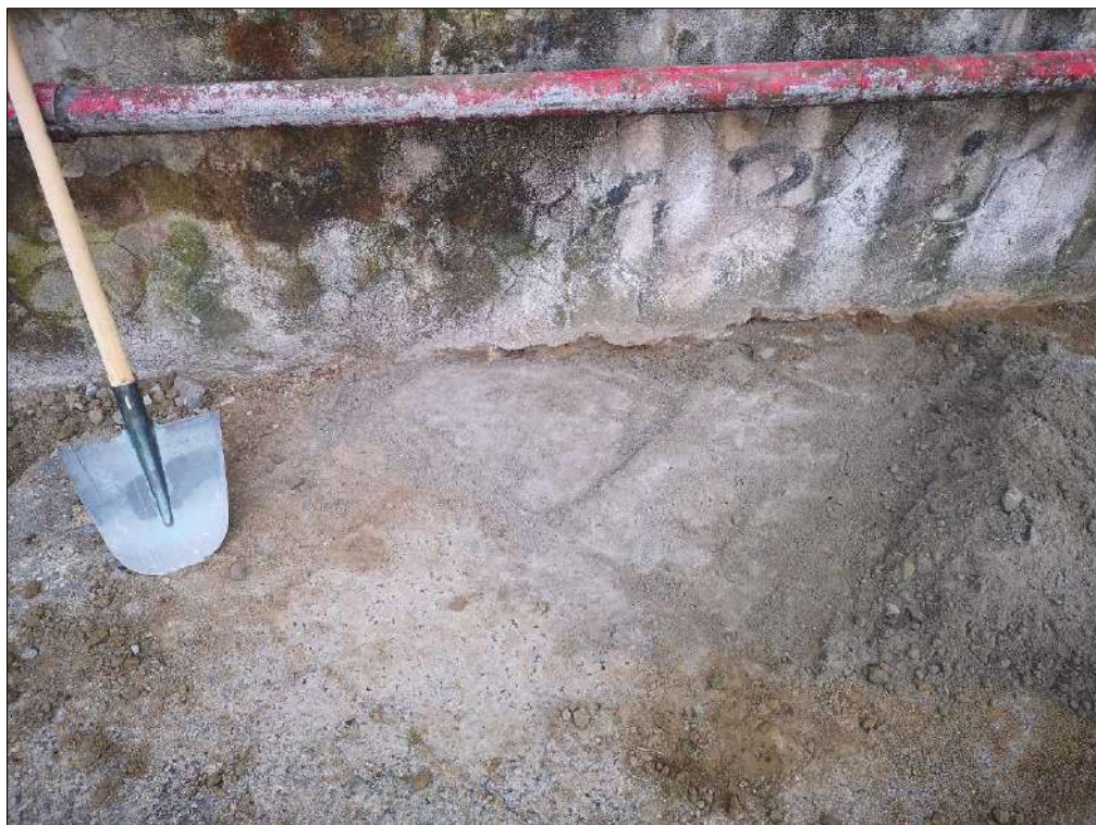
Foto 4: Ripristino dello stato dei luoghi scavo n° 1.
