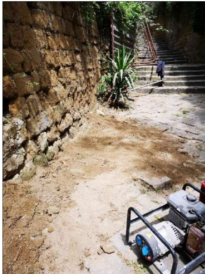
Foto 6: Ripristino dello stato dei luoghi.
