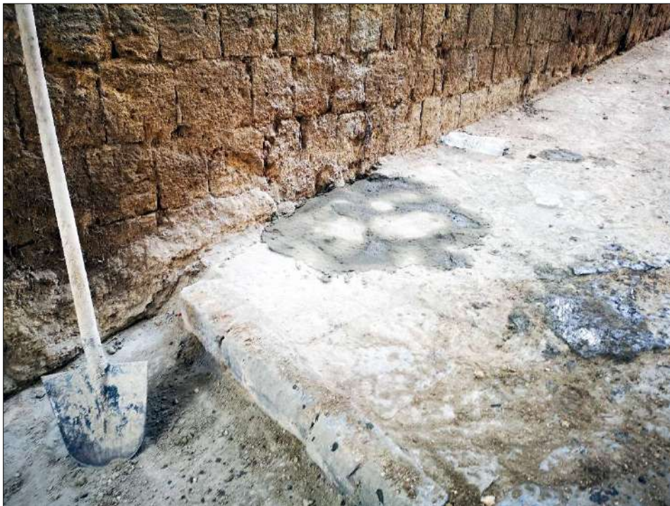
Foto 5: Ripristino dello stato dei luoghi.
