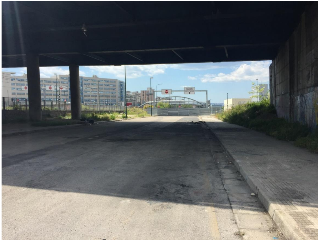
Figura 6: Via Domenico Rea verso parcheggio Ospedale del Mare
