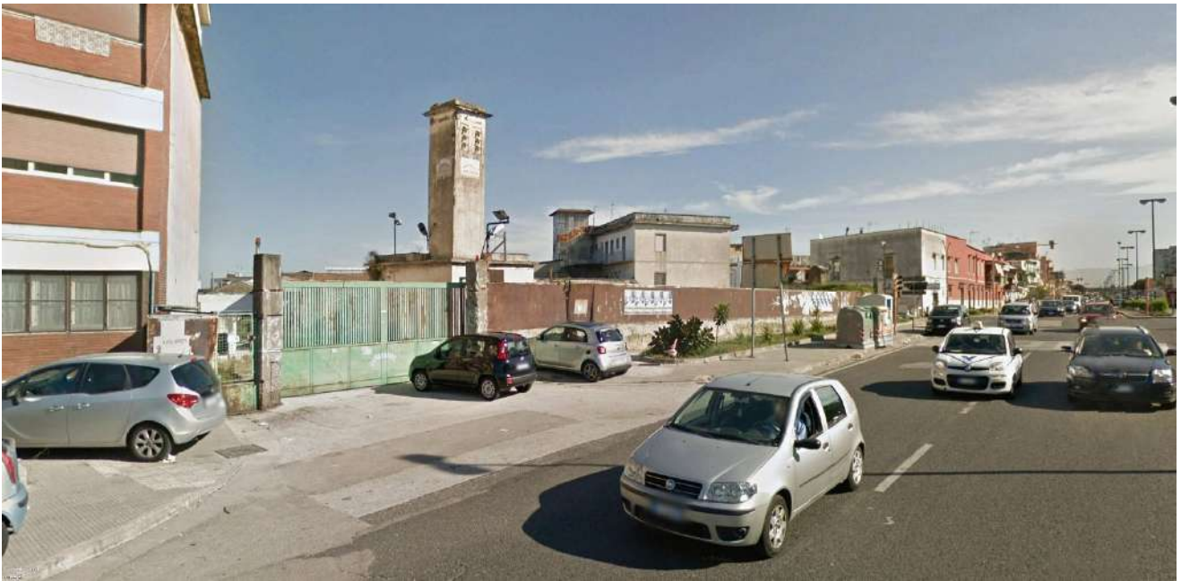
Vista da Via Argine - Stato di fatto
