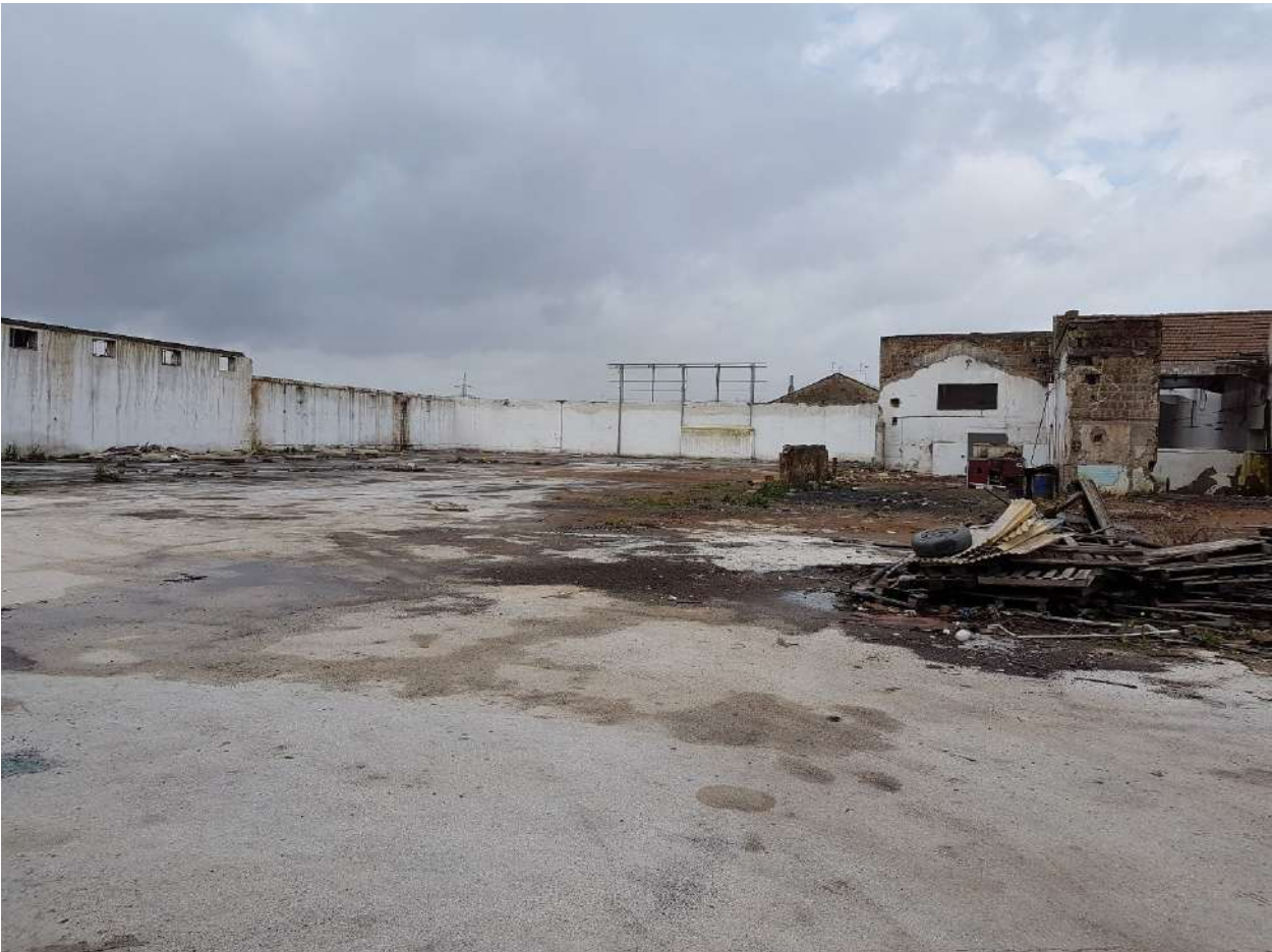
Stato dei luoghi_ l'area è completamente impermeabilizzata
