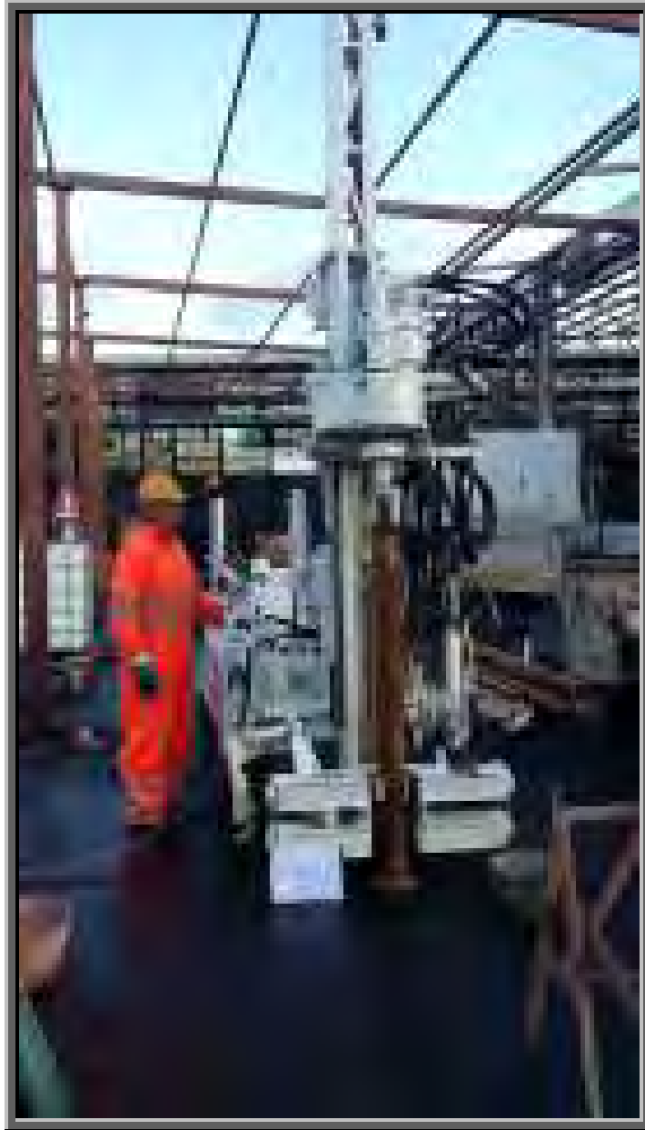
Piazzamento perforatrice per esecuzione Sondaggio "C1"
