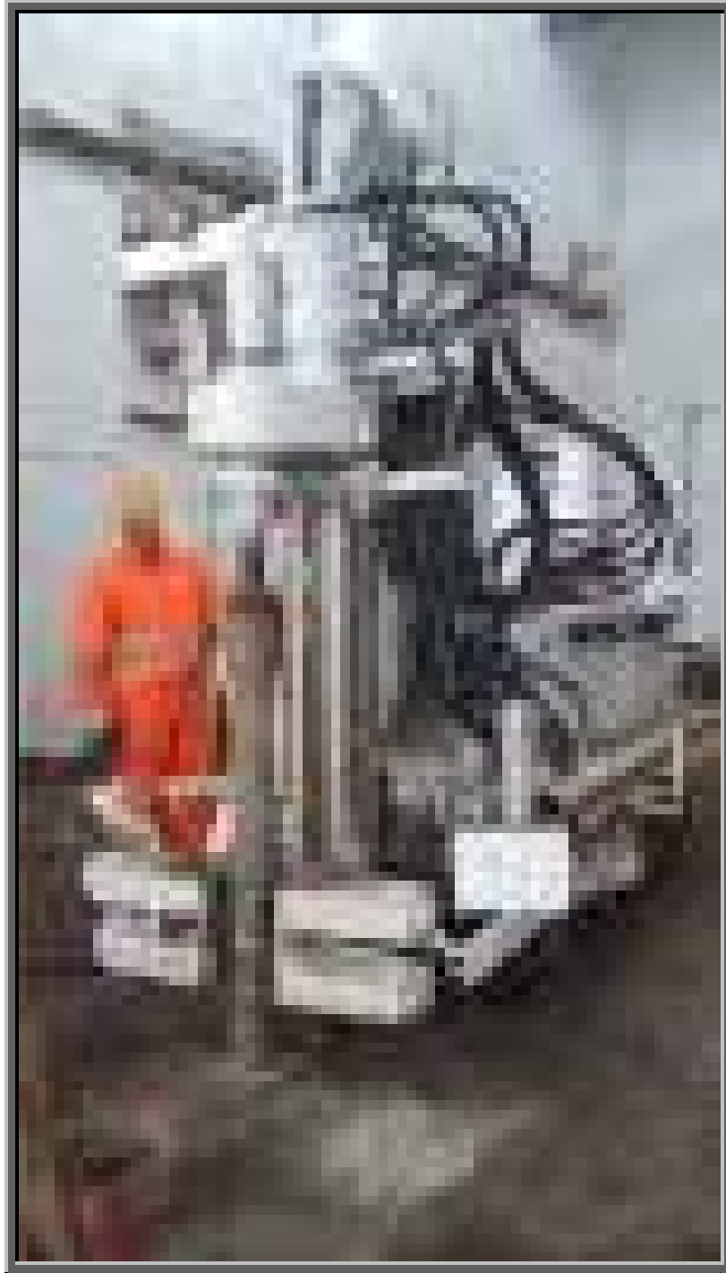
Piazzamento perforatrice per esecuzione Sondaggio "C3"
