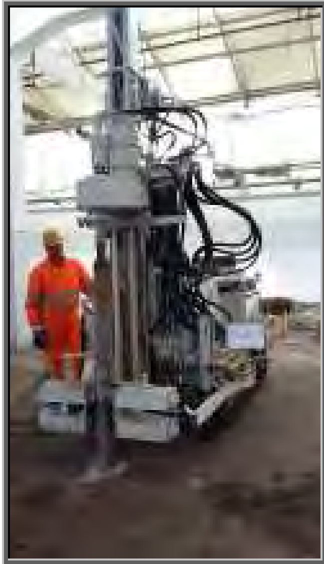
Piazzamento perforatrice per esecuzione Sondaggio "C6"
