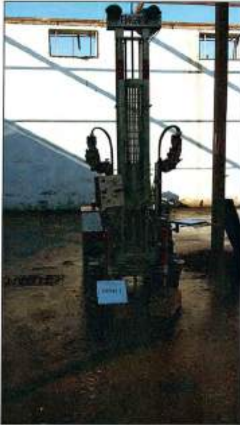
Particolare esecuzione prova DPHS P1
