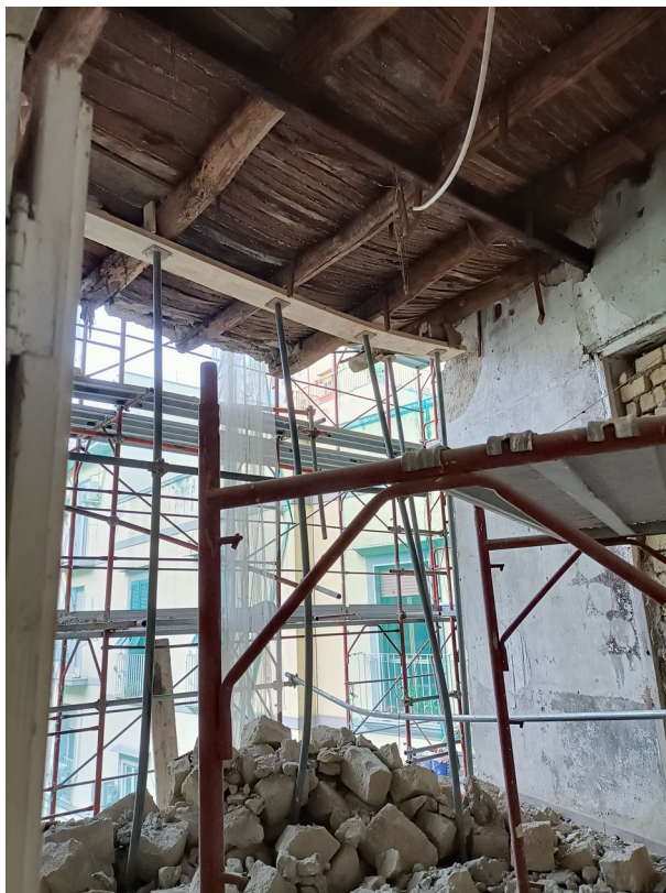
Foto 11 – puntellamento provvisorio e parziale che ha retto il solio
