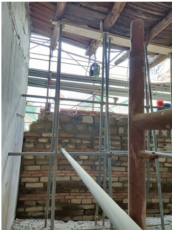
Foto 13 – ricostruzione della muratura
