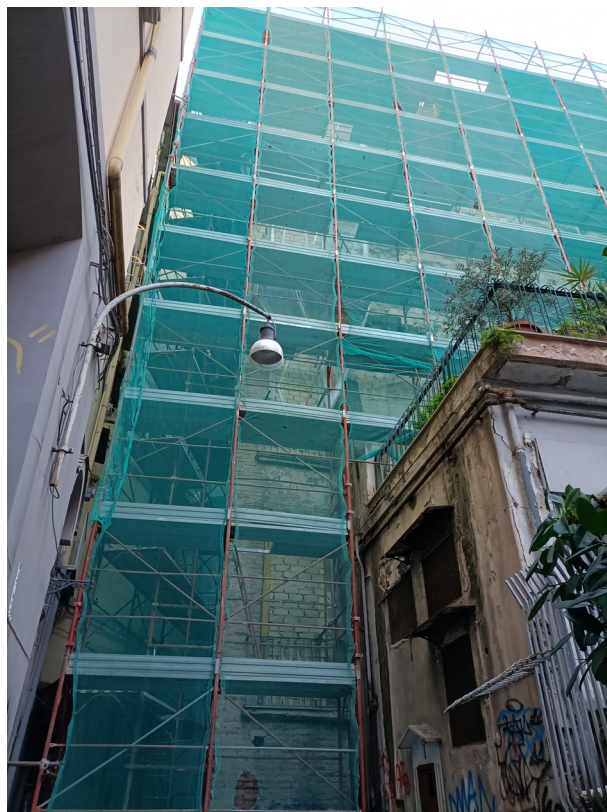
Foto 3 – ponteggio installato
