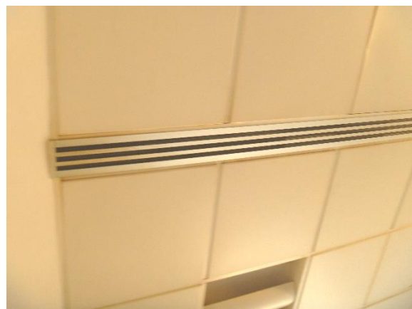
Figura 4.7 - Particolare dei diffusori ad aria incassati
