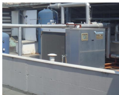
Figura 4.4 - Particolare di pompa di calore per unità consiliare
