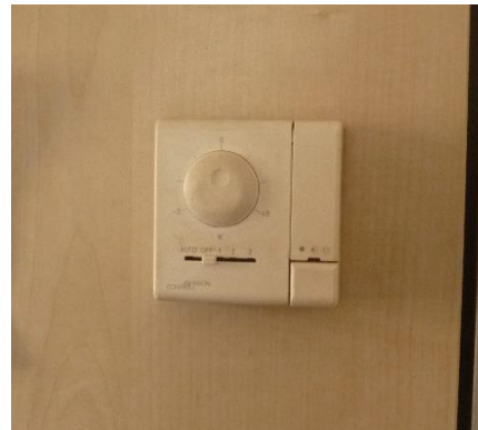
Figura 4.6 - Particolare di un termostato ambiente
