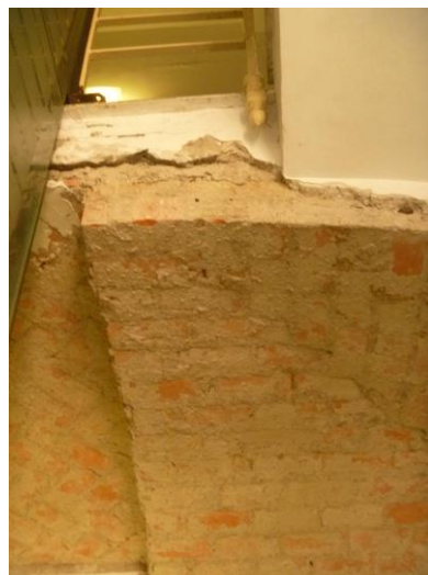
Figura 4.1 - Particolare della porzione di involucro
