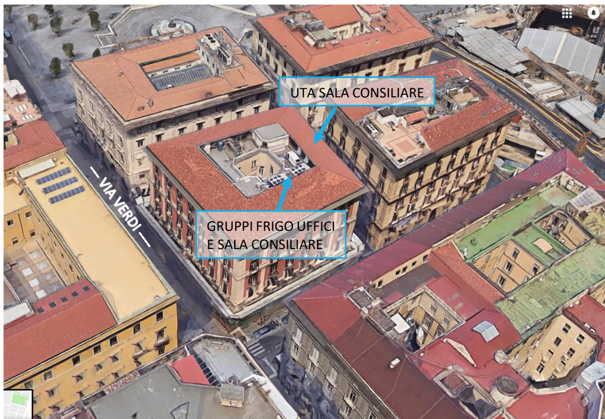
Figura 2.3 - Contesto esterno dell'edificio vista SO, con individuazione dei principali componenti d'impianto.
