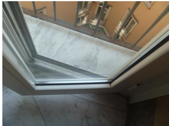
Figura 4.2 - Particolare dei serramenti
