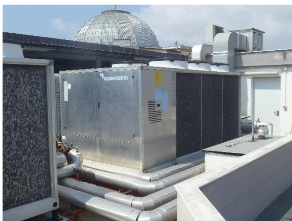
Figura 4.3 - Particolare di pompa di calore principale
