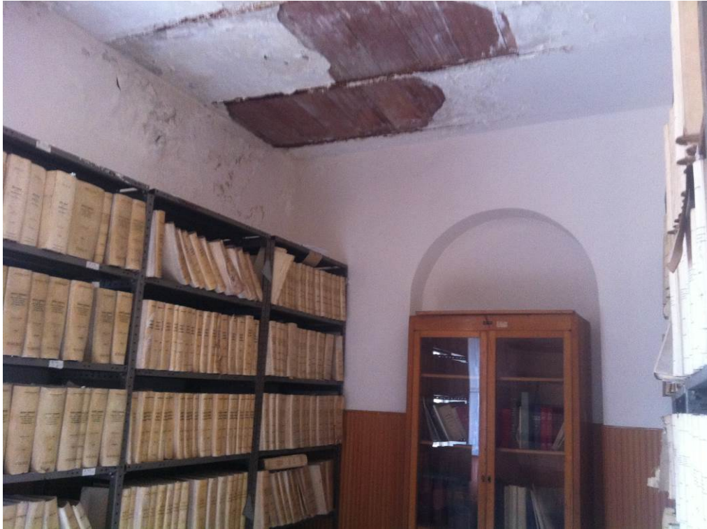
Foto 23: piano primo, aula con accesso diretto dalla sala dell'archivio storico comunale.
