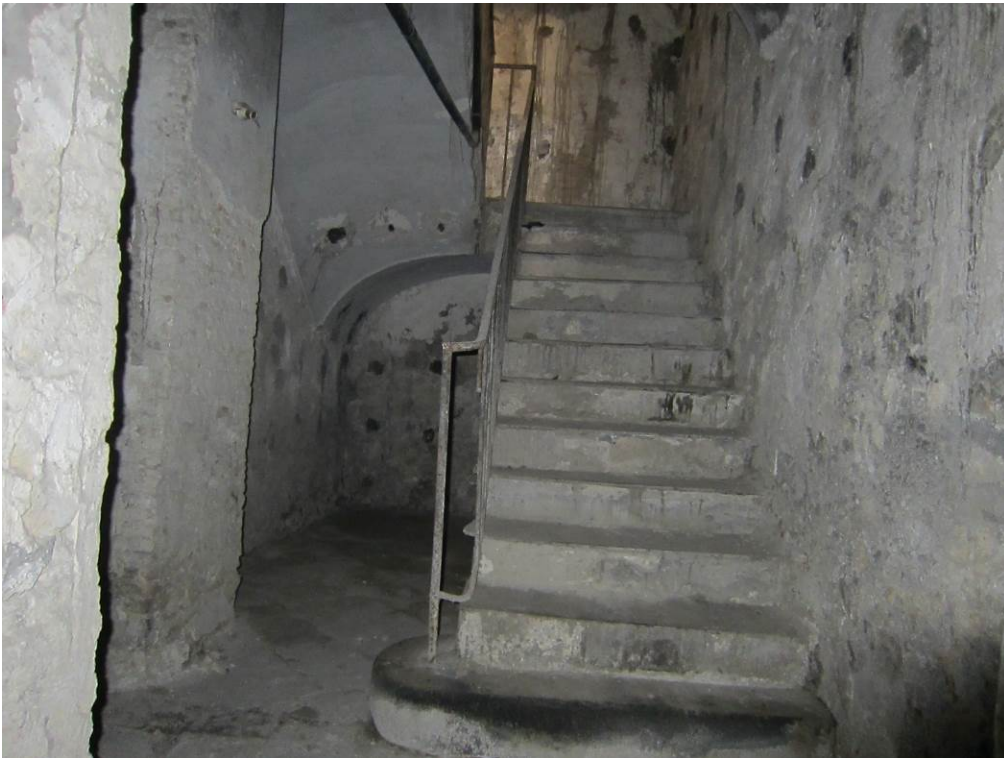
Foto 6: scala in muratura, a doppia rampa, su voltine.
