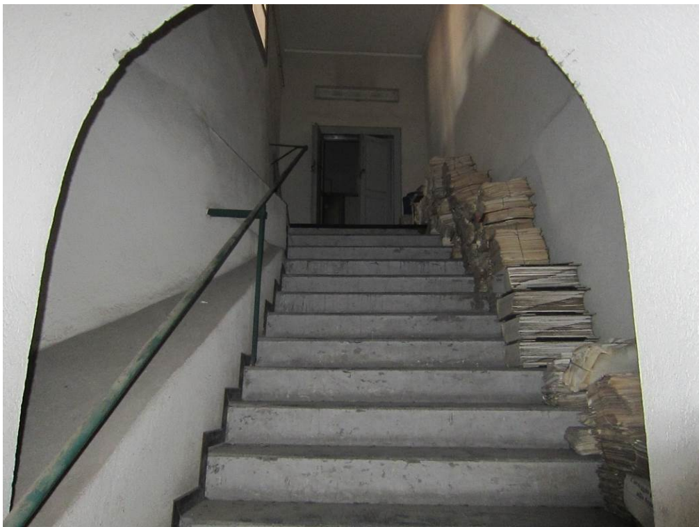
Foto 25: rampa di collegamento fra il livello ammezzato ed il primo piano.
