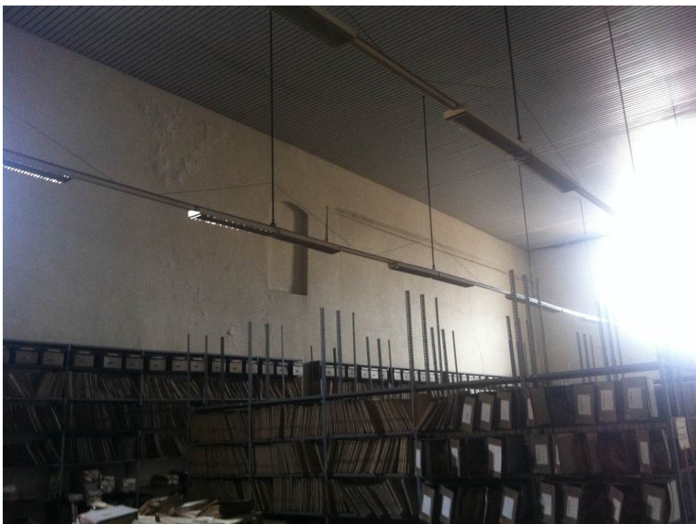
Foto 21: piano primo, sala dell'archivio storico comunale.
