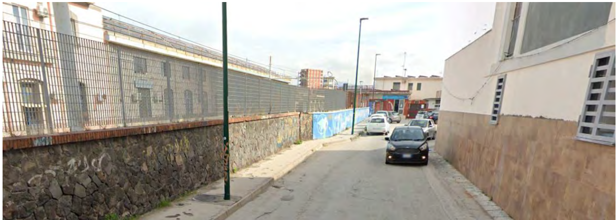
Figura 34 – Report fotografico Via Murrelle
