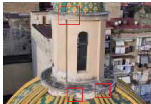
Particolare degrado lanterna-ossidazione ferri c.a.
