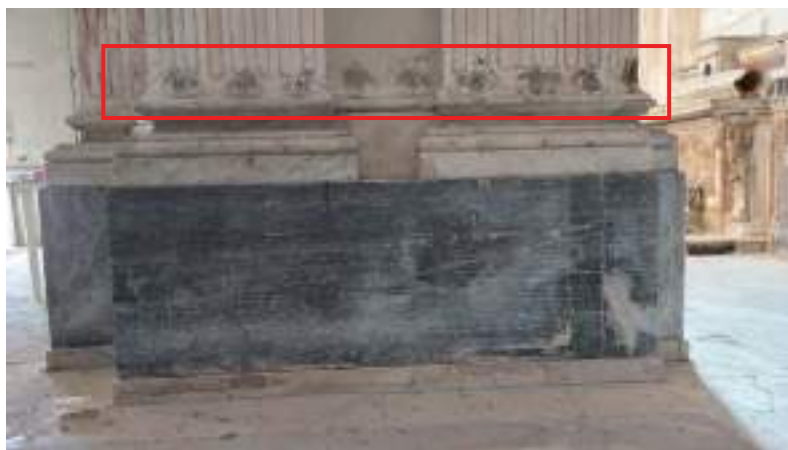
Particolare delle perforazioni
