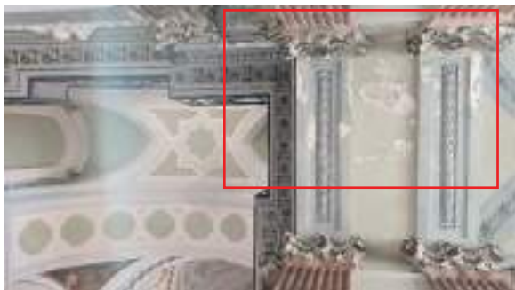
Interni: infiltrazioni - presenza umidità e distacchi pellicola pittorica
