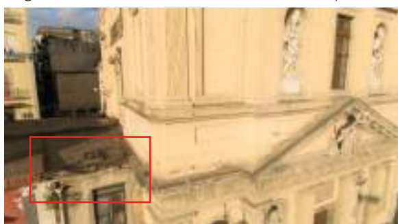
Infiltrazioni e danni provenienti da strutture adiacenti
