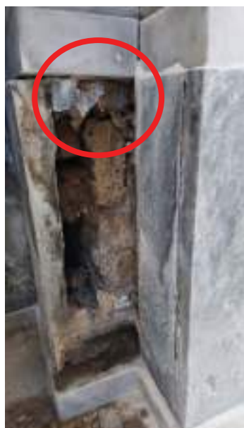
Danneggiamenti da perni ossidati
