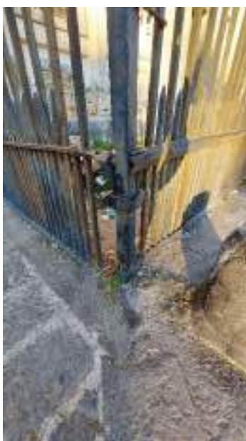
Degrado degli elementi di ancoraggio dei pannelli e degli ancoraggi a terra
