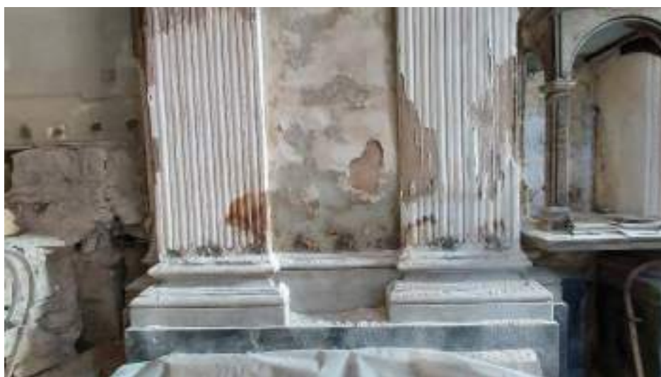
Pareti interne: stato di degrado degli intonaci di pareti e paraste
