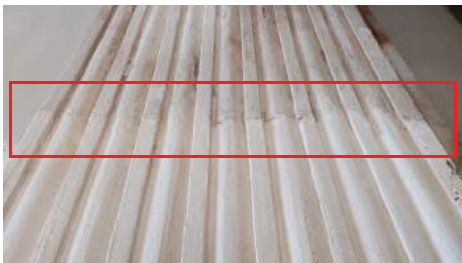
Paraste interne: In evidenza la linea di demarcazione tra i diversi materiali utilizzati – presenza di "armature" con chiodi
