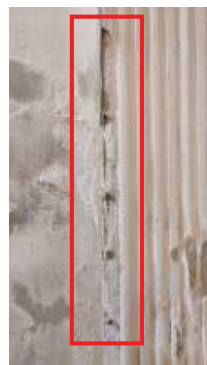
Paraste interne: In evidenza la linea di demarcazione tra i diversi materiali utilizzati – presenza di "armature" con chiodi
