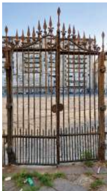
Degrado degli elementi di ancoraggio dei pannelli e degli ancoraggi a terra
