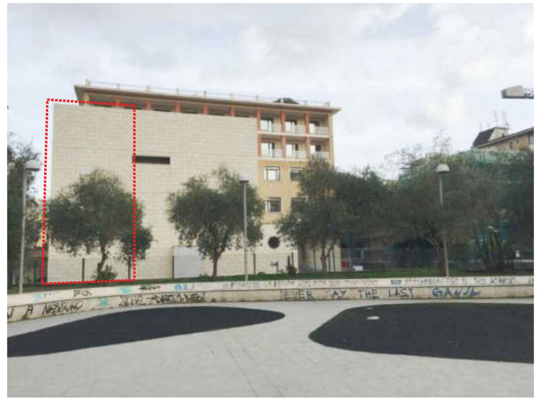
FOTO 1 - La facciata da via Montedonzelli
