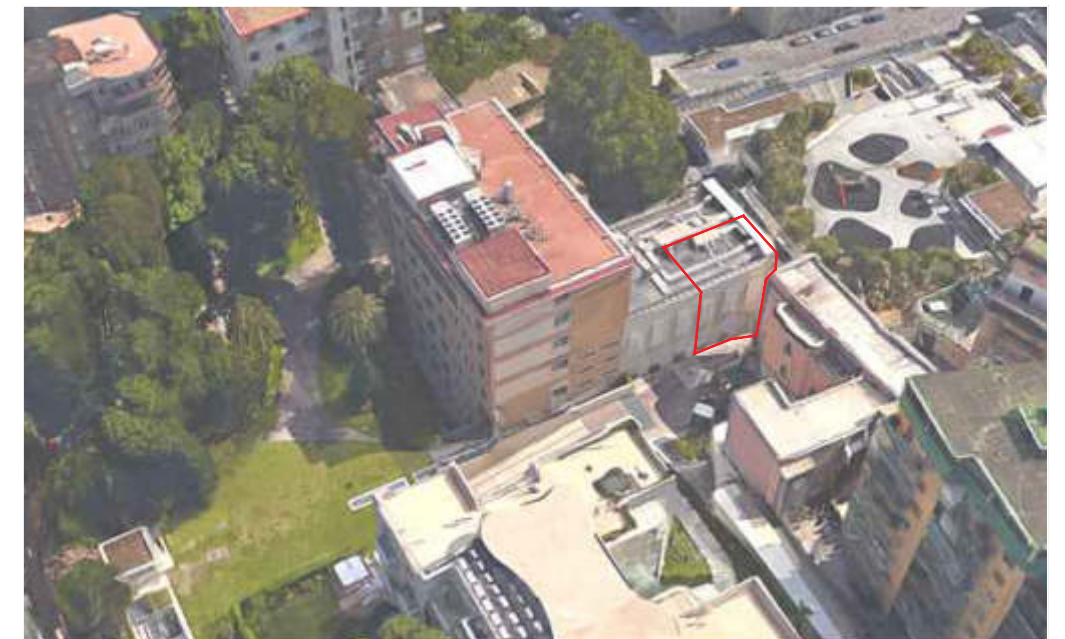
Vista da nord - ovest dell'edificio
