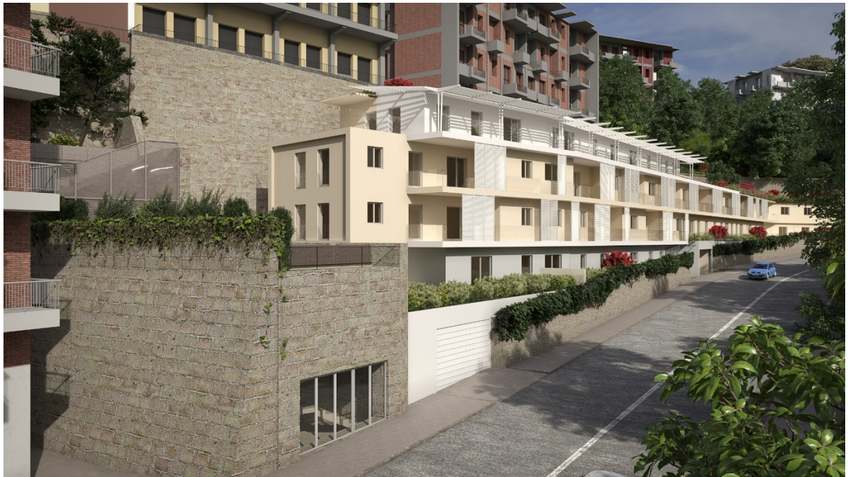
15: Edificio via Caravaggio lato valle
