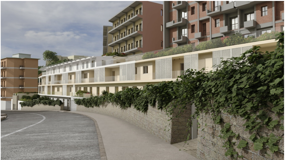
14: Edificio via Caravaggio lato valle
