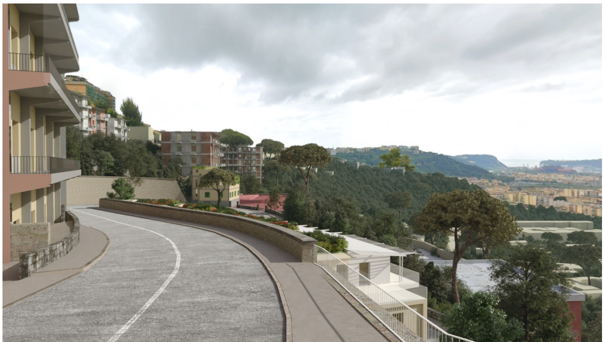
13: Edificio contenuto nel salto di quota stradale
