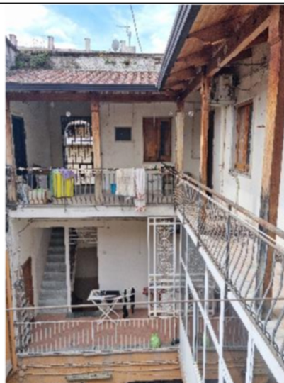
n.34 - Vista esterna del sub.14
