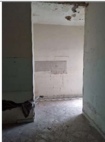
n.8 – Vista vano 4
