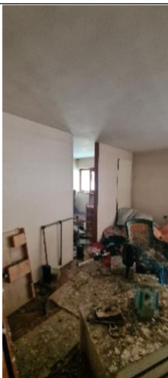
n.9 – Vista vano
