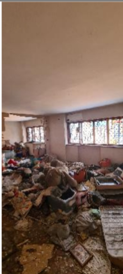
n.7 – Vista vano
