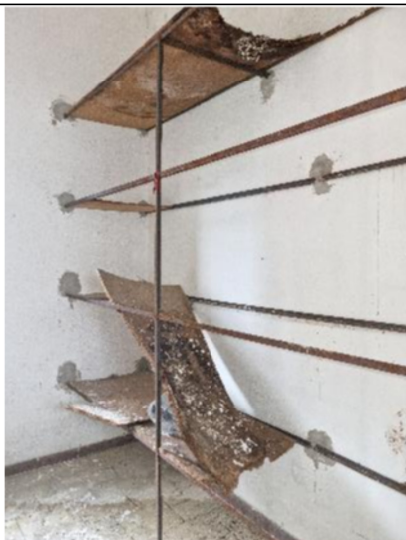
n.45 - Vista vano - sub.13
