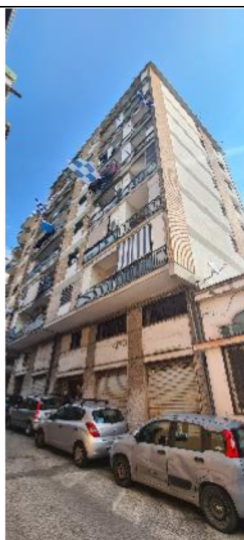
n.1 – Vista fabbricato
