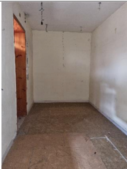
n.37 – Vista vano - sub.17
