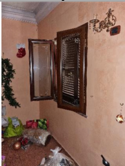
n.23 - Vista vano – sub.12
