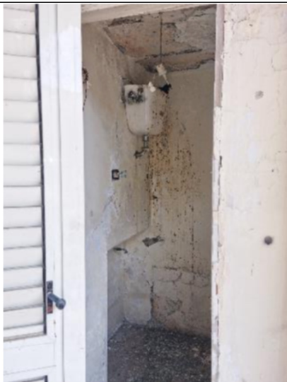
n.41 – Vista locale - sub.17
