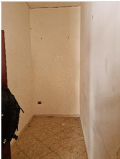
n.19 - Vista ingresso – sub.7
