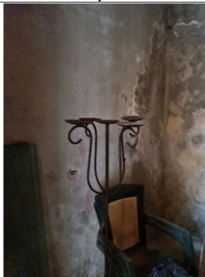
n.16 - Vista locale deposito – sub.4 o sub.18
