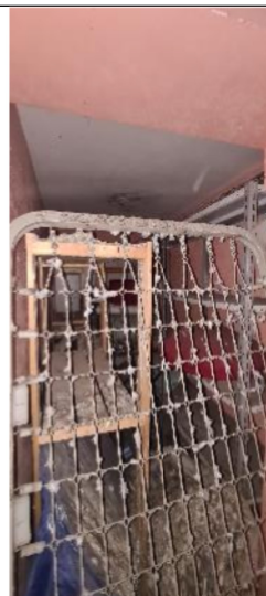
n.12 – Vista wc
