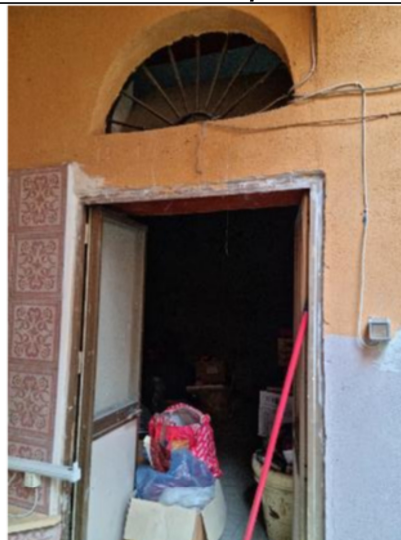
n.12 – Vista accesso locale deposito – sub.4 o sub.18
