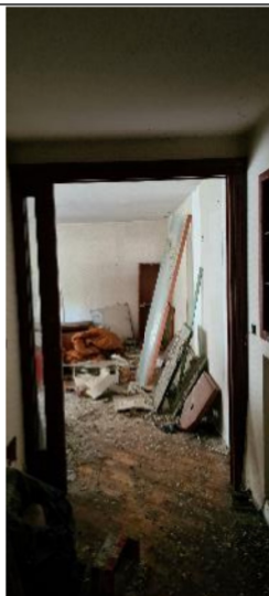
n.5 – Vista vano dal disimpegno
