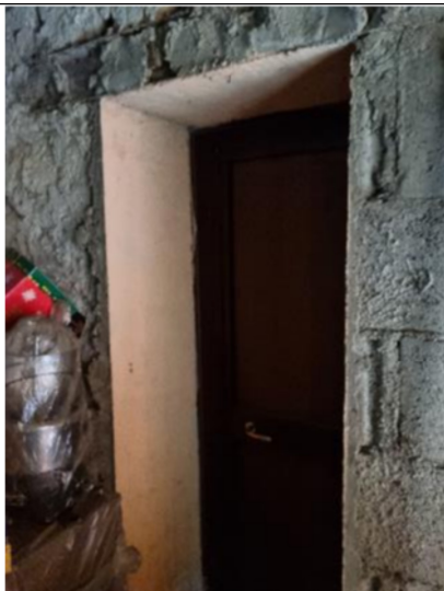
n.13 - Vista locale deposito – sub.4 o sub.18
