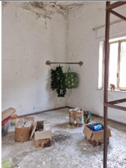
n.43 - Vista vano - sub.13
