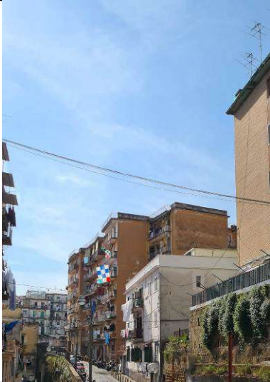
n.1 – Vista esterna
