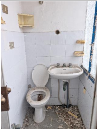
n.47 - Vista wc - sub.13
