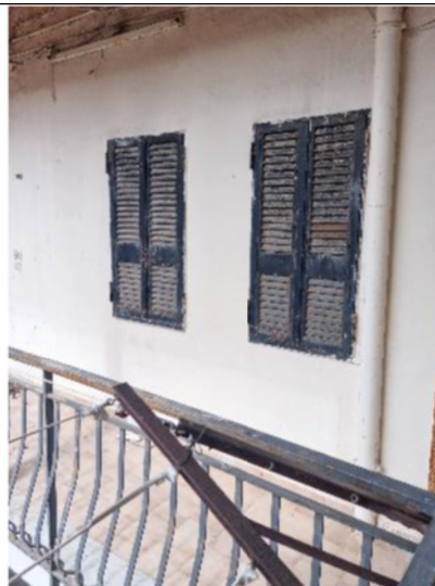
n.32 - Vista esterna - sub.16
