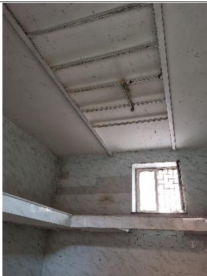
n.7 – Vista locale deposito – sub.6
