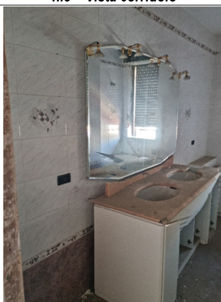
n.10 – Vista wc
