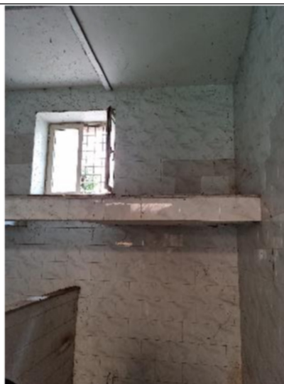
n.6 – Vista locale deposito – sub.6
