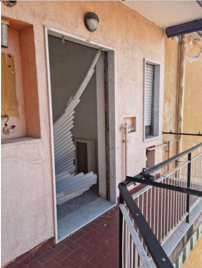
n.5 – Vista balcone
