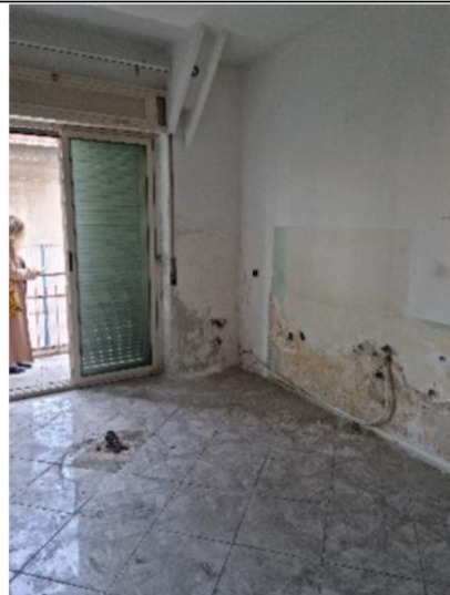
n.6 – Vista vano 1
