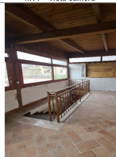
n.16 – Vista piano primo
