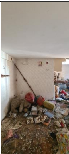
n.11 – Vista vano
