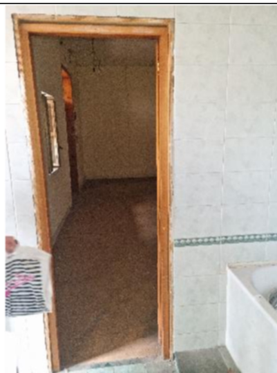
n.36 - Vista wc - sub.17
