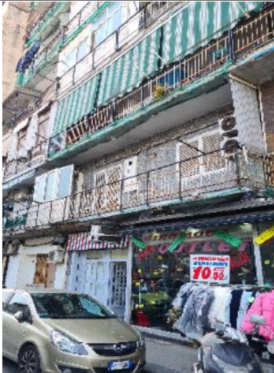
n.1 – Vista esterna
