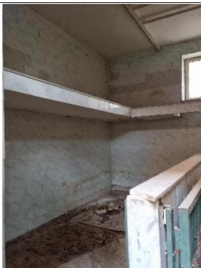
n.5 – Vista locale deposito – sub.6
