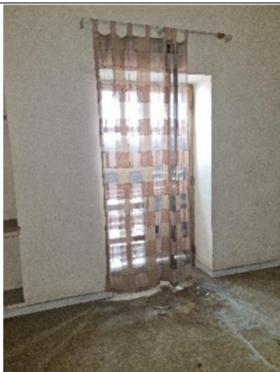
n.39 – Vista locale - sub.17
