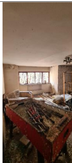
n.10 – vista vano
