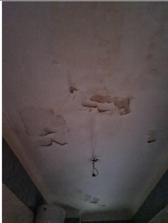
n.10 – vista infiltrazione
