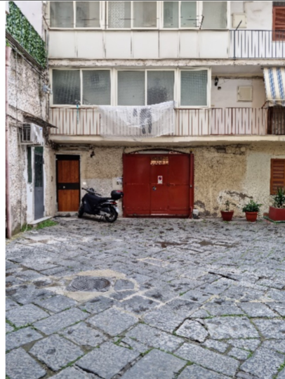
n.2 – Vista accesso tramite cancello pedonale/carrabile sulla p.lla 47
