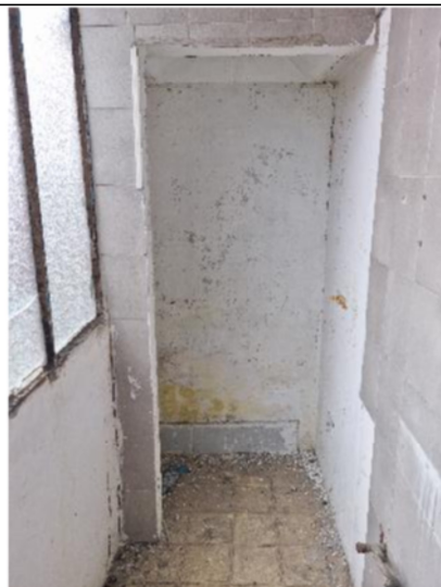
n.46 - Vista wc - sub.13
