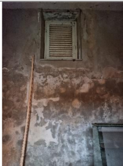
n.14 - Vista locale deposito – sub.4 o sub.18
