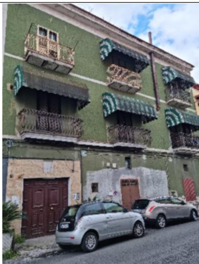
n.1 – Vista esterna
