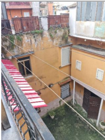
n.33 - Vista esterna
