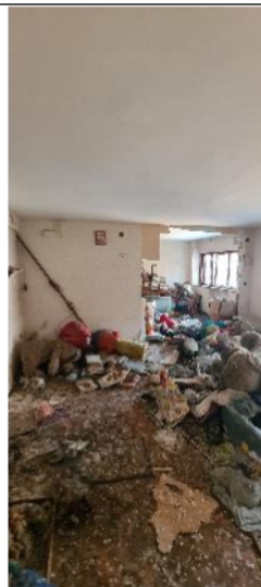
n.6 – Vista vano
