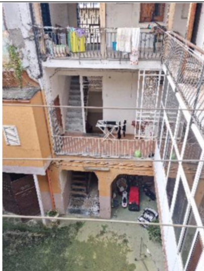
n.31 - Vista cortile dal ballatoio del P2
