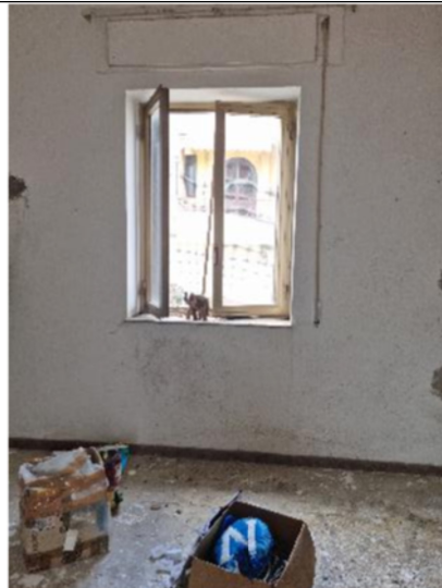
n.44 - Vista vano - sub.13
