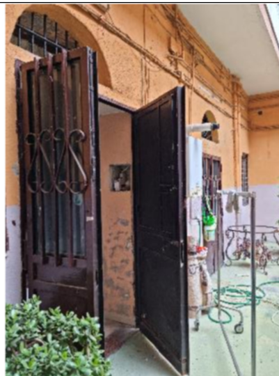
n.8 – Vista accesso locale deposito sub.3
