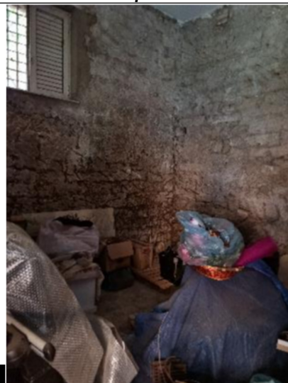
n.15 - Vista locale deposito – sub.4 o sub.18
