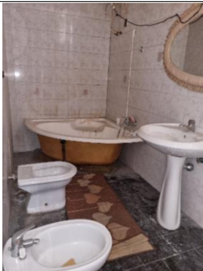
n.29 - Vista wc – sub.16
