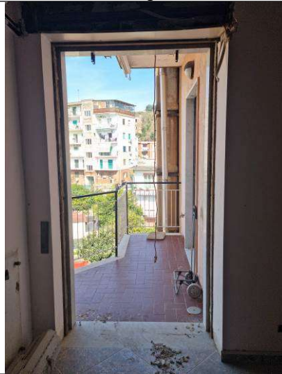
n.4 – Vista balcone
