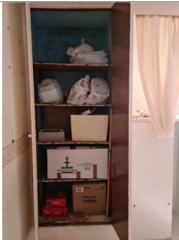
n.12 – vista dettaglio armadio a muro
