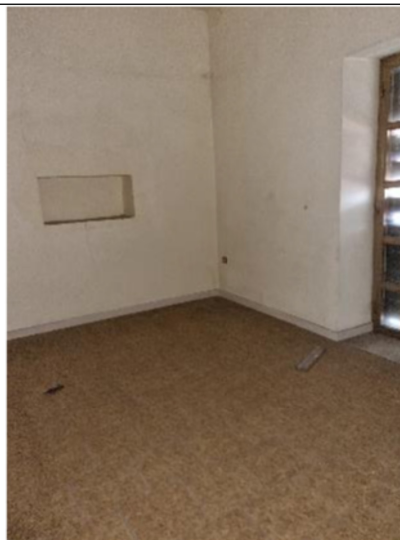
n.40 – Vista locale - sub.17
