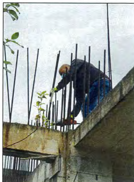
Figura 14: Prelievo campione di armatura PB2
