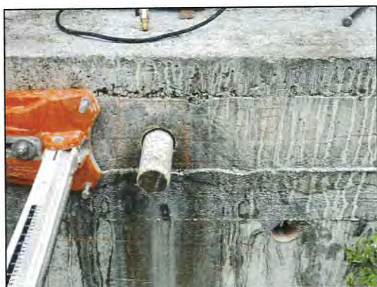
Figura 5: Estrazione carota cls C6
