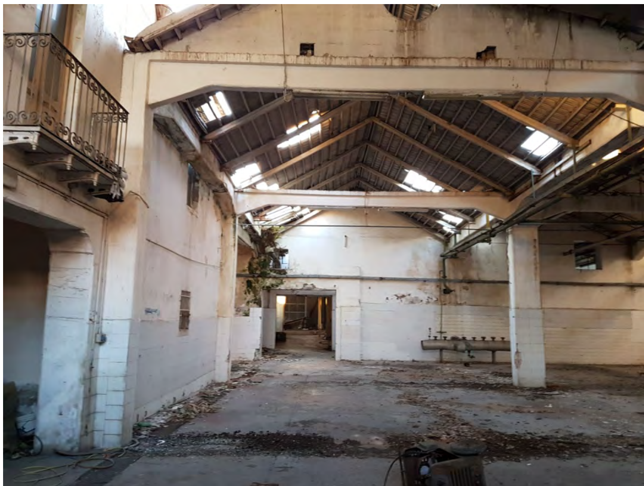
Interno di uno degli edifici esistenti, realizzato in muratura portante mista a pilastri e travi in cemento armato. La copertura è composta da arcarecci in legno e manto di tegole.
