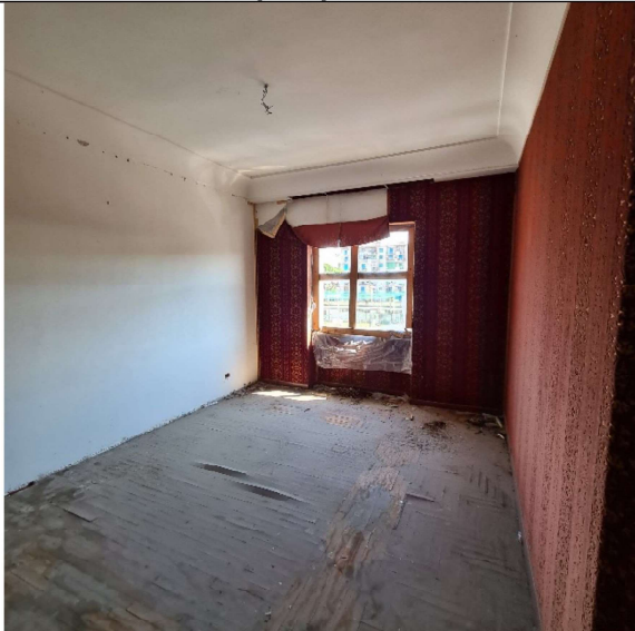
n.11 – Vista vano
