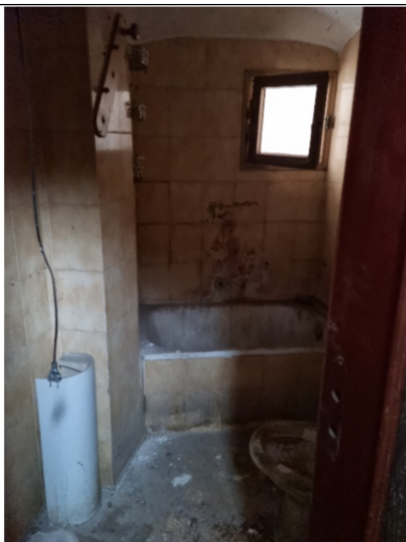
n.7 – Vista wc
