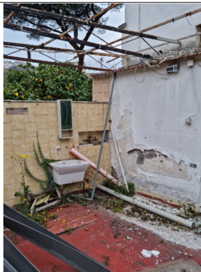
n.8 – Vista terrazzo sud
