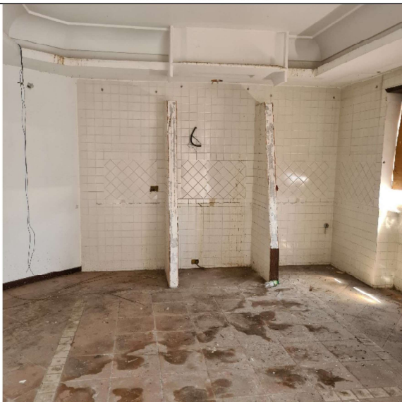
n.5 – Vista vano
