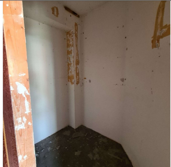
n.8 – Vista ripostiglio
