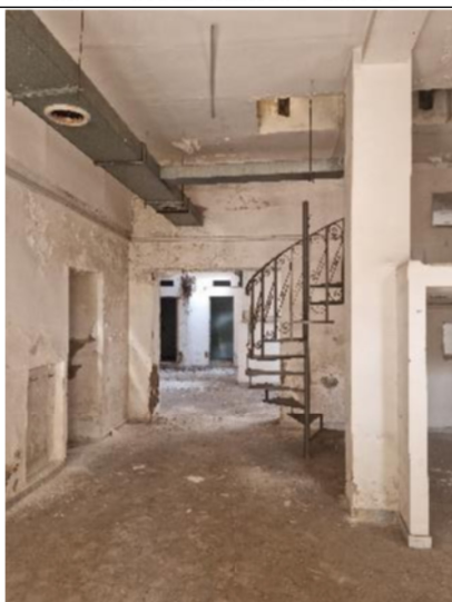
n.3 – Vista vano
