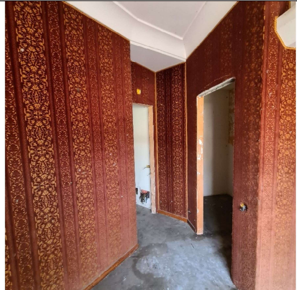
n.12 – Vista vano
