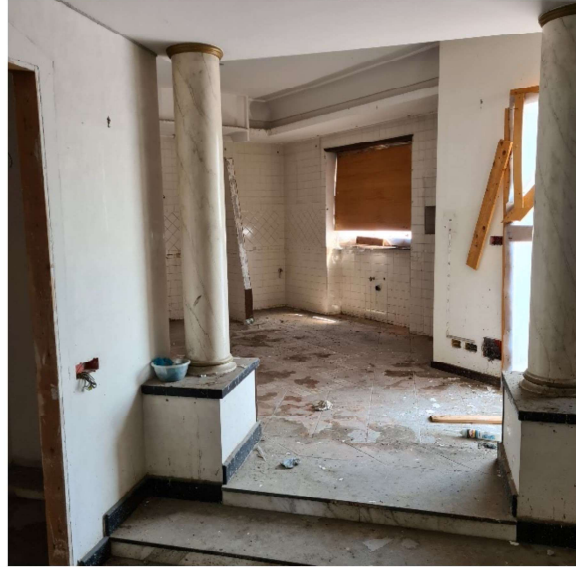
n.4 – Vista vano
