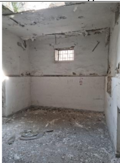
n.6 – Vista vano
