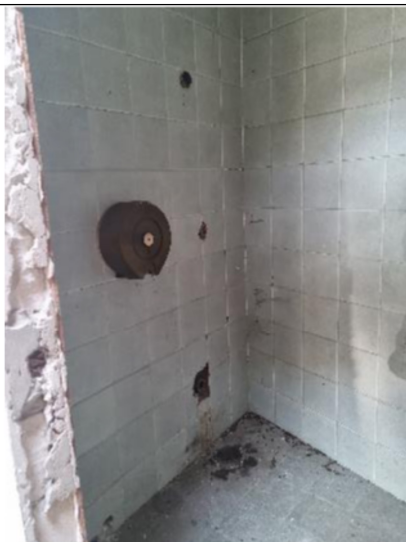
n.7 – Vista wc
