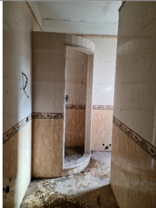
n.10 – Vista wc – piano primo
