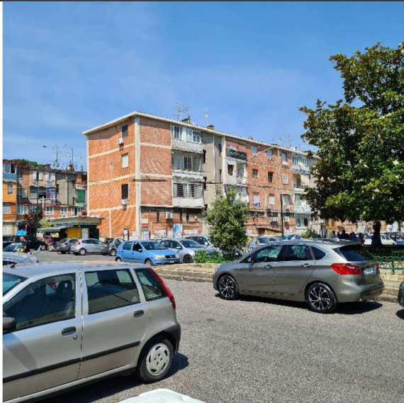
n.1 – Vista esterna
