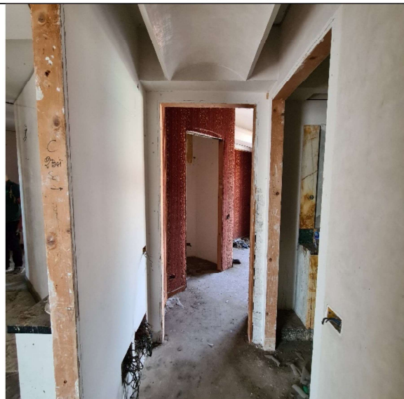
n.6 – Vista vano
