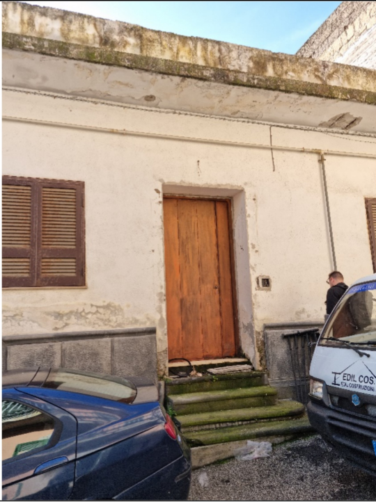
n.1 – Vista esterna
