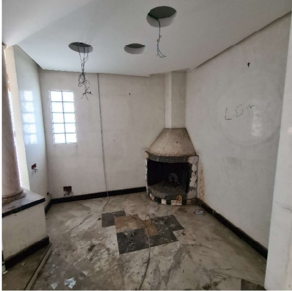
n.3 – Vista vano
