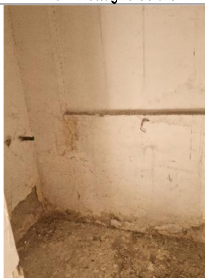
n.12 – Vista ripostiglio
