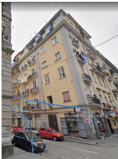
n.12 – Vista fabbricato
