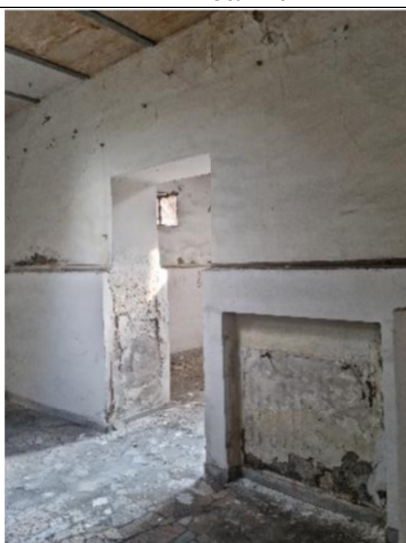
n.9 – Vista vano
