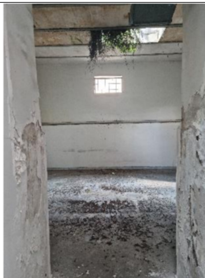
n.8 – Vista vano
