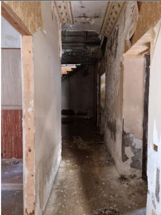
n.3 – Vista corridoio – piano terra
