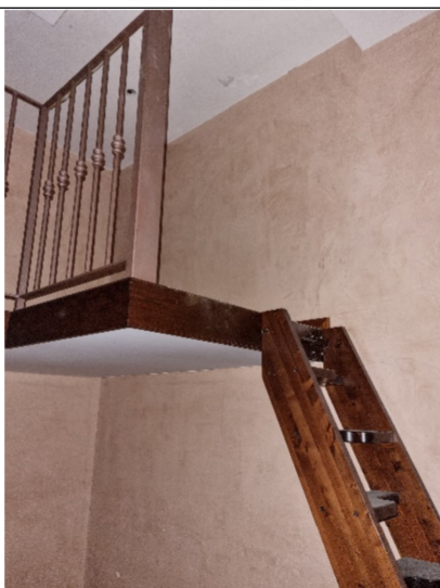
n.11 – Vista soppalco
