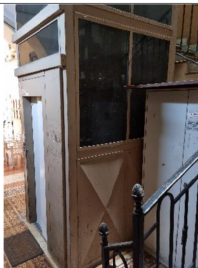
n.2 – Vista ascensore
