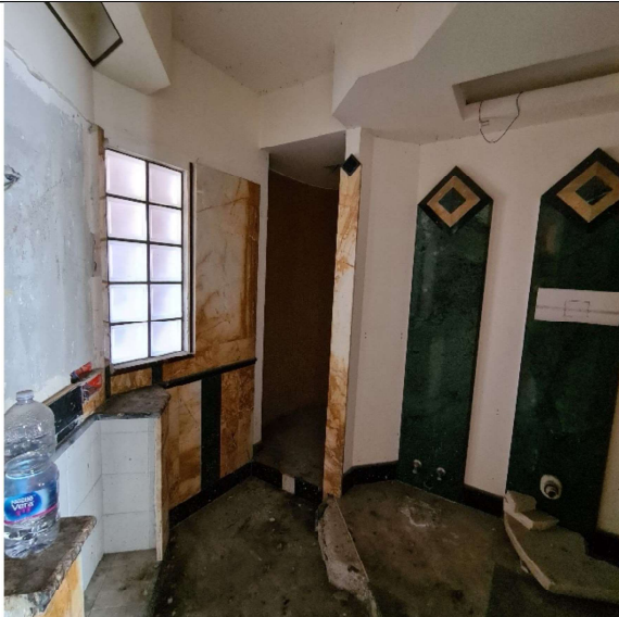
n.7 – Vista wc n.1
