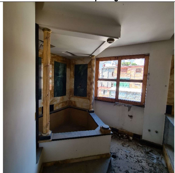
n.10 – Vista wc n.2
