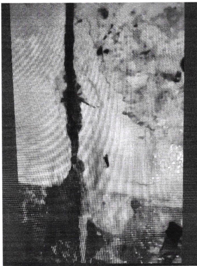
Locale civico 244 di piazza mercato: infiltrazioni Origine delle infiltrazioni: rottura tubazione idrica nella parete adiacente
