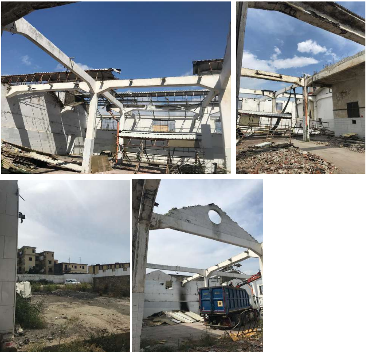
Foto relative alle operazioni di messa in sicurezza e di smontaggio delle coperture esistenti.
