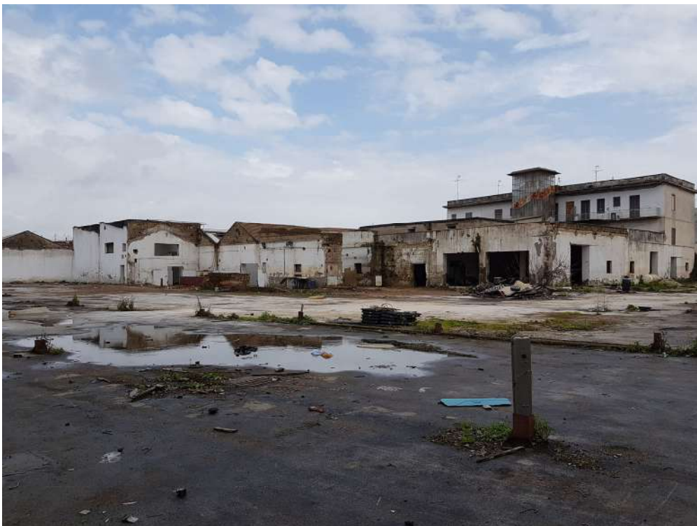
Foto del complesso industriale oggetto dell'intervento
