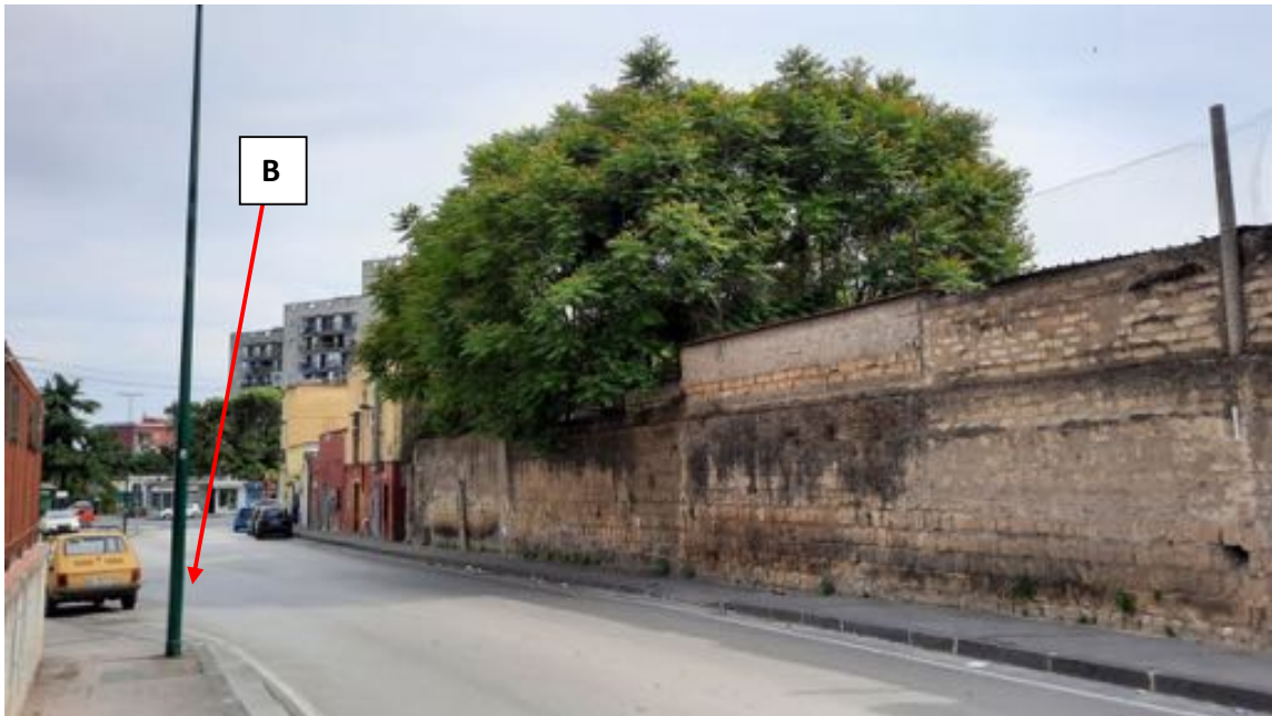
Foto n. 6 – Il punto di misura B, ubicato lungo via Provinciale Cupa del Principe
