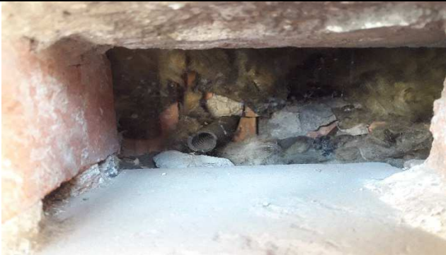
Dettaglio che rivela la presenza dell'isolante nella stratigrafia
