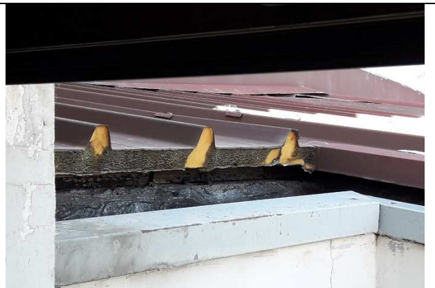
Dettaglio dell'estradosso della copertura con finitura in poliuretano tra lamiera sigillate
