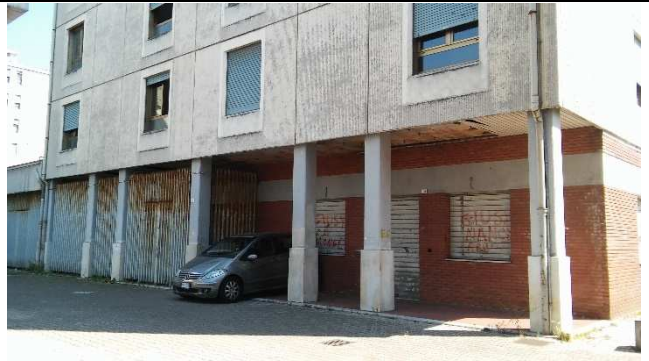
Dettaglio dei pannelli prefabbricati in cls presenti in facciata
