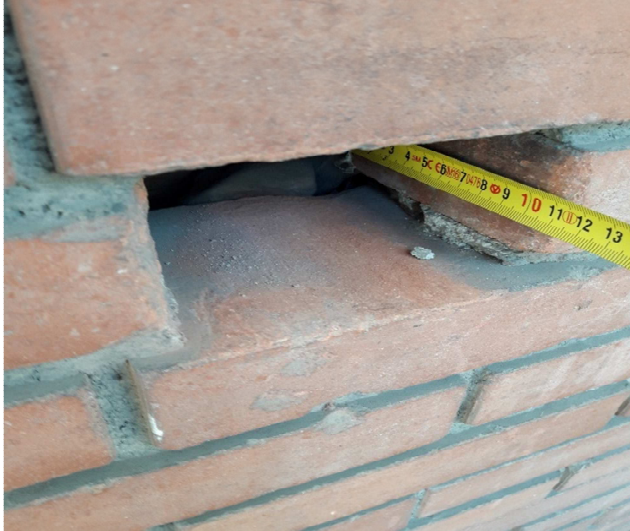
Misurazione dello spessore del paramano che costituisce lo strato esterno della muratura
