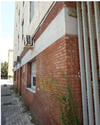
Dettaglio della muratura in paramano del piano terreno
