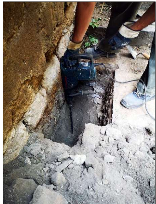
Foto 8: Scavo n° 2 ultimato.
