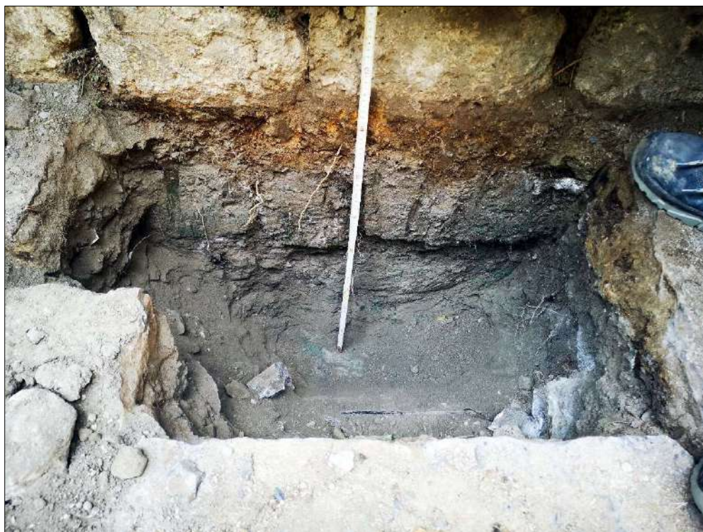
Foto 9: Scavo n° 2 ultimato in coincidenza di un livello di cemento fuso su cui è posizionata la fondazione
