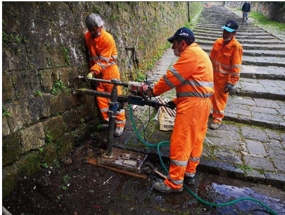
Foto 4: Micro carotaggio n° 1 alla base della prima rampa della scala.
