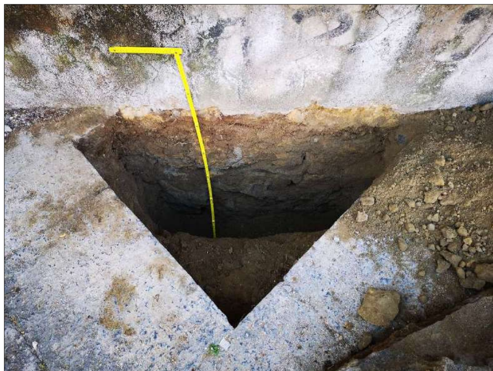
Foto 2: Panoramica dello scavo n° 1.
