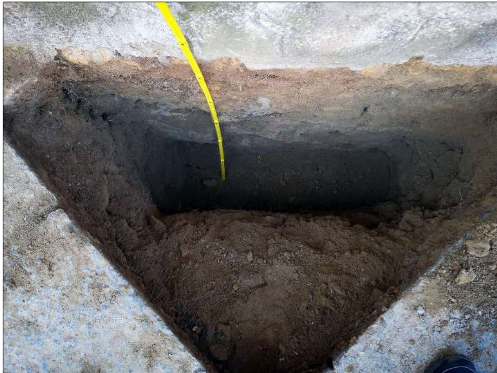
Foto 3: Panoramica dello scavo n° 1.
