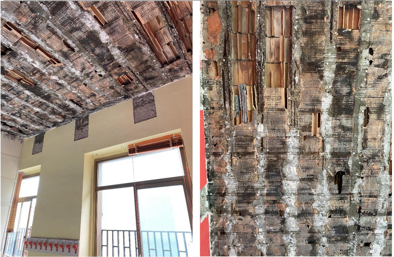
Figura 8-9: Saggio solaio - Aula 2
