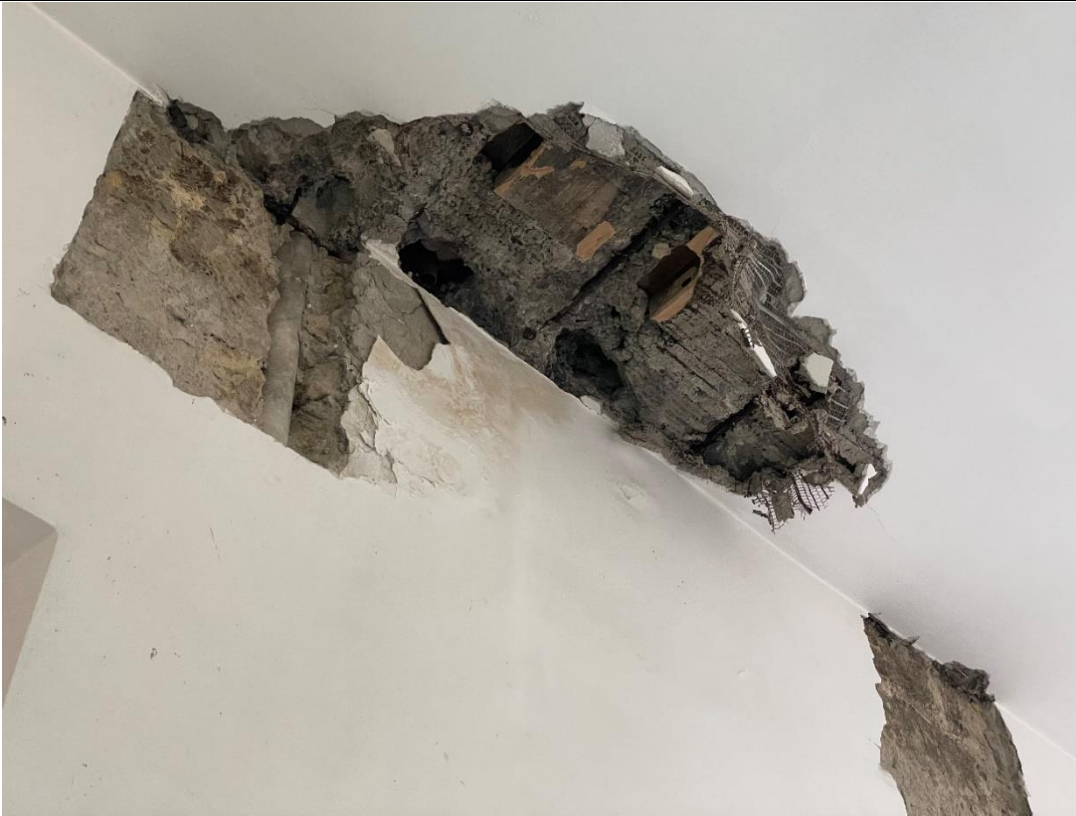
Figura 4: Blocco bagni prospiciente l'Aula 2
