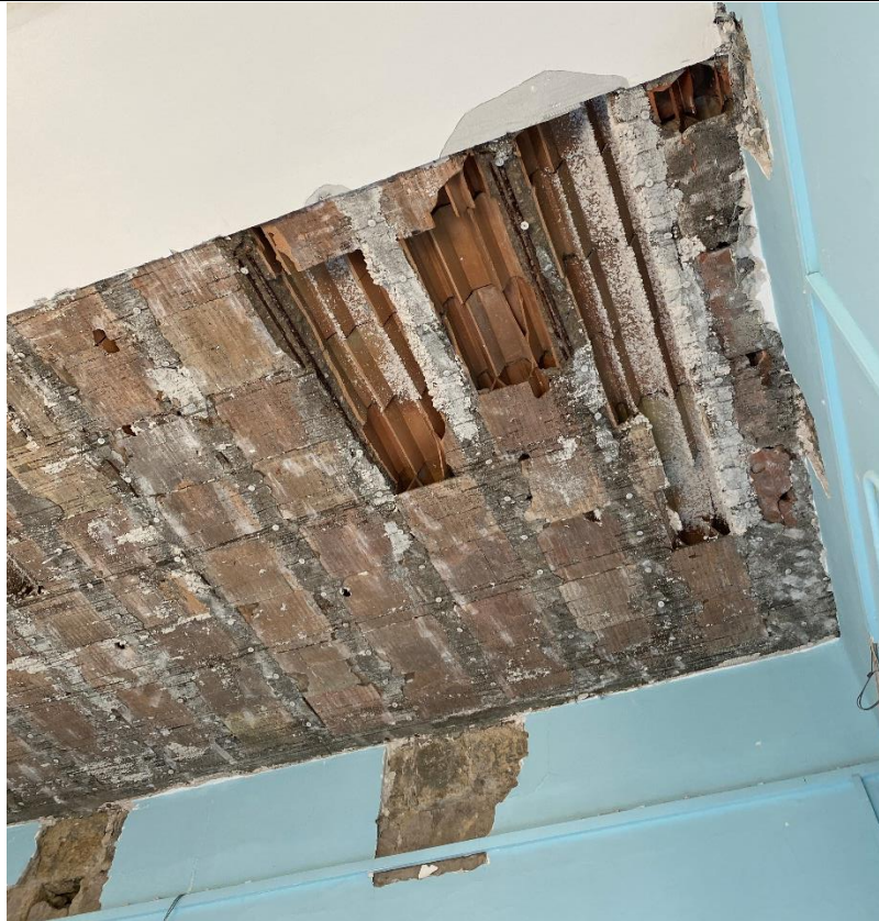
Figura 10: Saggio solaio - Aula 1
