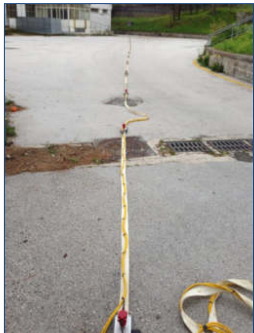
Foto 3 – Prospezione sismica MASW 2. A monte del fabbricato E.
