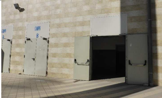
Immagine relativa al pacchetto di muratura oggetto di indagine
