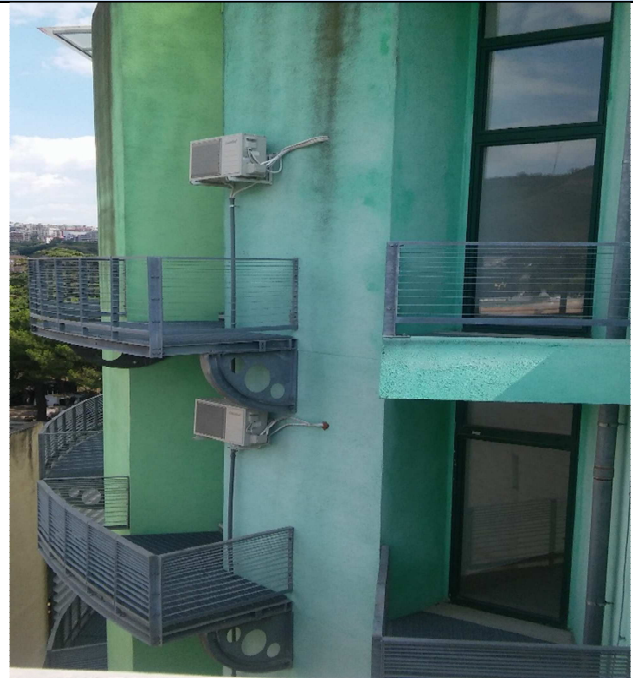
Dettaglio dell'esterno della muratura
