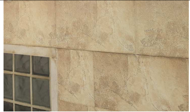
Dettaglio del rivestimento esterno della muratura
