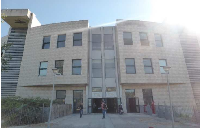
Ingresso all'edificio sul fronte sud-ovest
