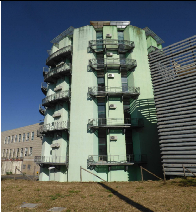
Immagine relativa al pacchetto di muratura oggetto di indagine
