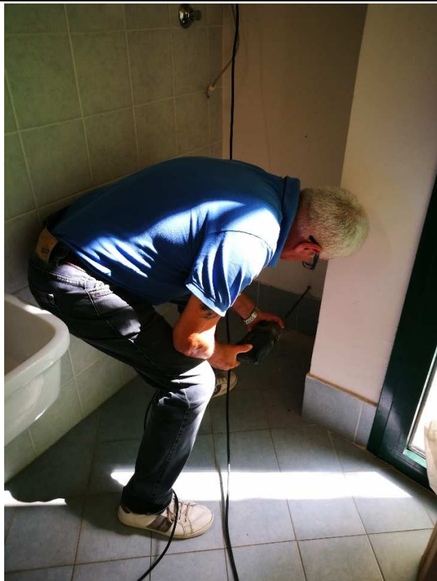
Immagine dei saggi murari effettuati dal Comune di Napoli
