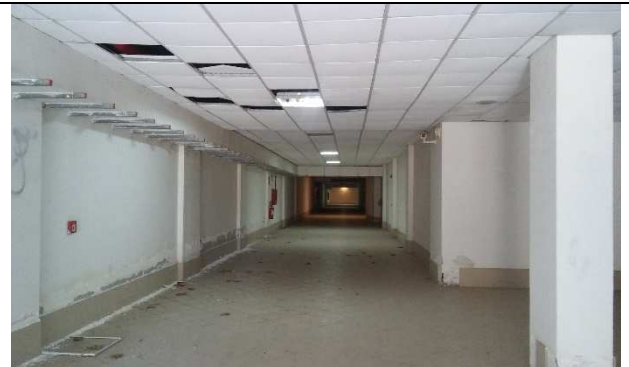
Immagine interna dei corridoi del piano interrato
