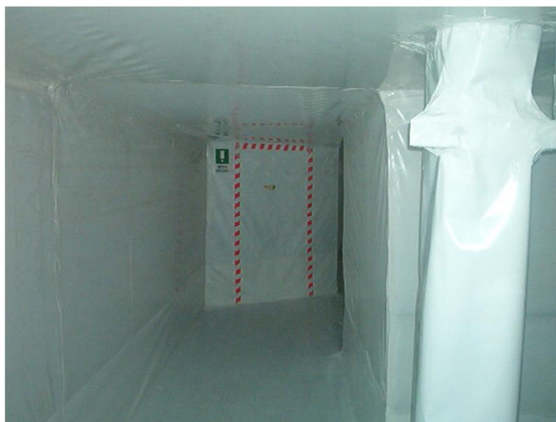
**Figura 2: Confinamento statico - Uscita di emergenza**
