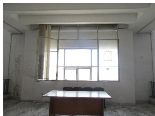
Figura 4.2 - Particolare dei serramenti in alluminio
