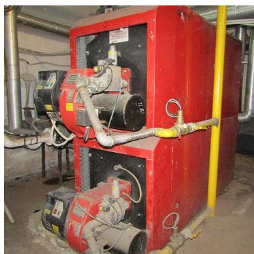
Figura 4.3- Particolare del generatore a combustione modello “Duomax”
