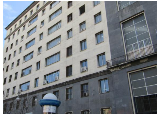
Figura 4.1 - Particolare della porzione di facciata
