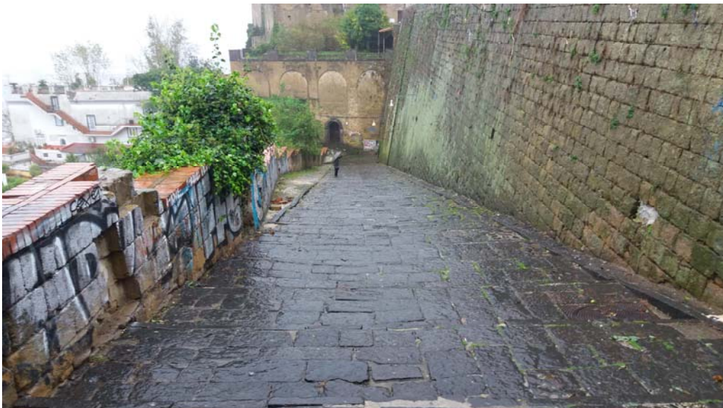
Figura 3 - via Pedamentina : tratto iniziale sprovvisto di caditoie
