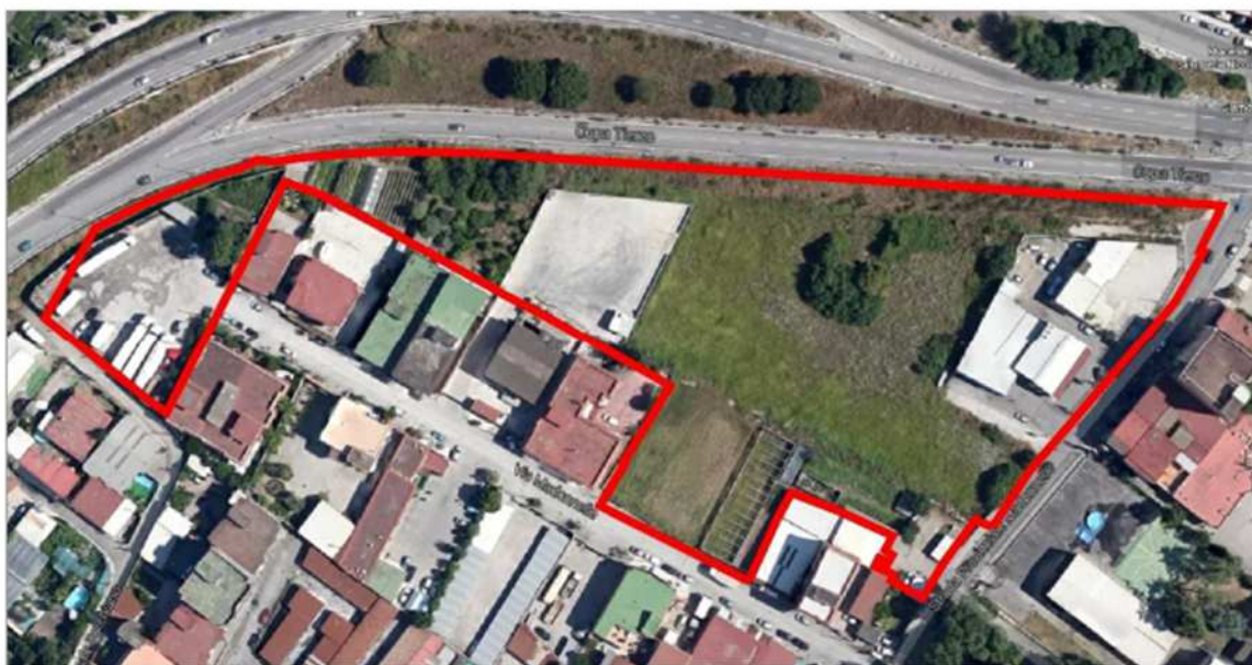
Foto aerea con evidenziazione dell'area oggetto di intervento
