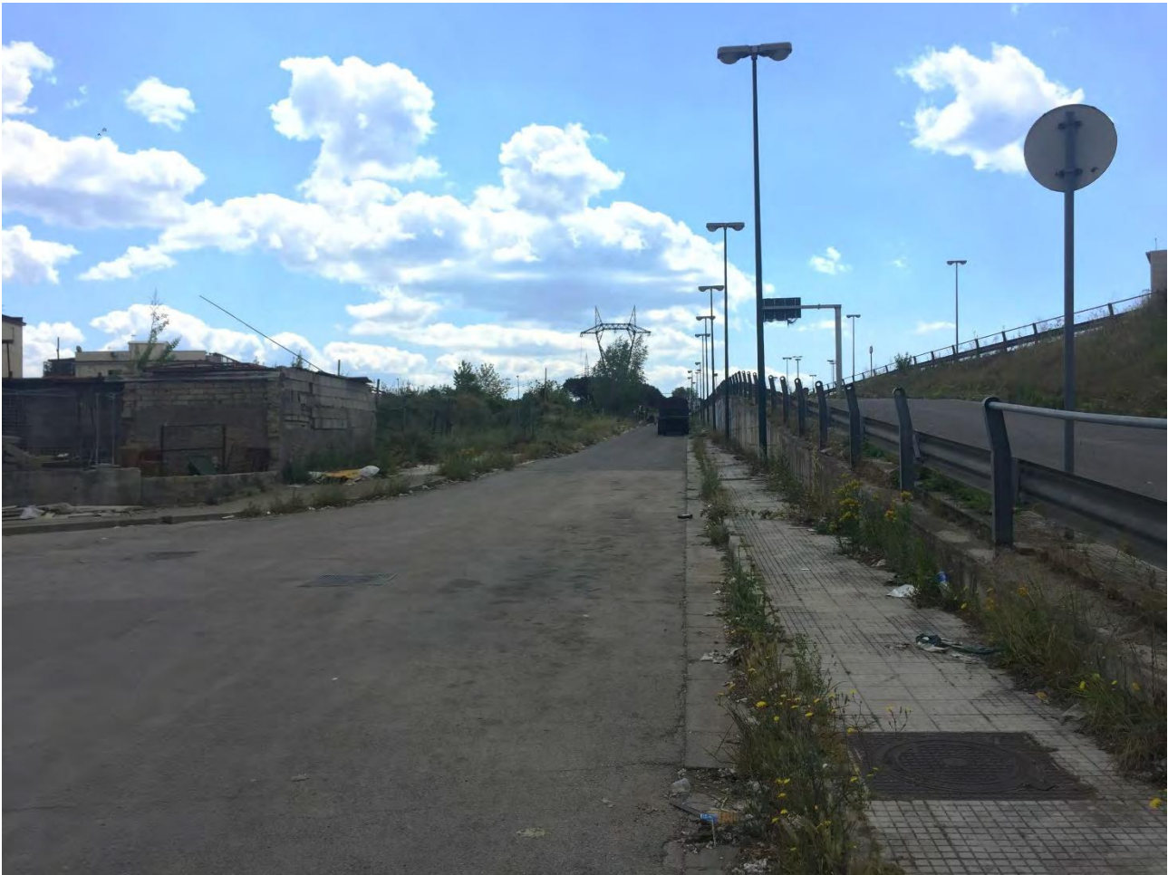
Foto 5: Via Domenico Rea – Sulla destra rampa di accesso per Via Domenico Rea .
