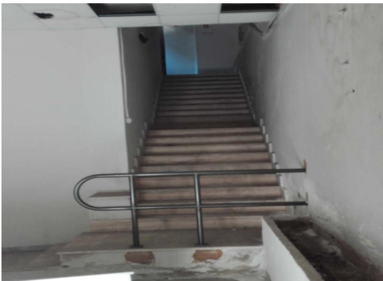
Foto n. 29. Vista della scala di accesso all'immobile in strada privata Nicolini 45 C posto al primo piano
