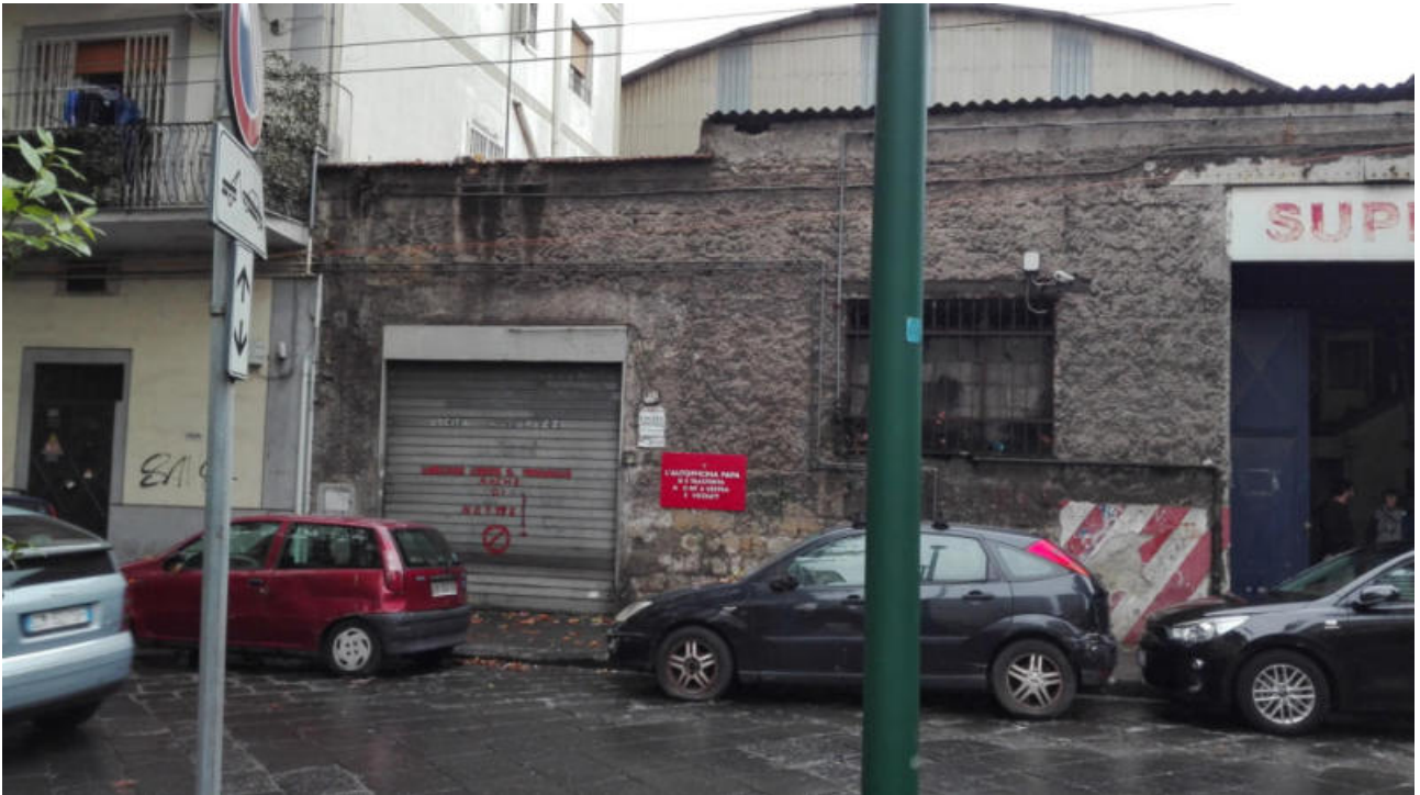
Foto n. 3. Via Nicola Nicolini, vista del locale di altra proprietà posto a sinistra dell'area d' ingresso
