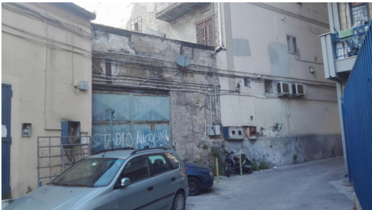
Foto n. 25. Strada privata via Nicolini n. 45. Controcampo
