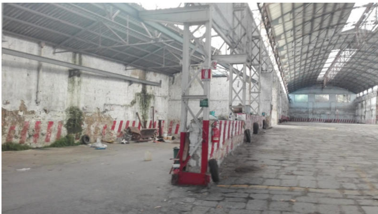
Foto n. 12. Vista interna del locale. Il capannone centrale con copertura a volta ed i capannoni lato sud.
