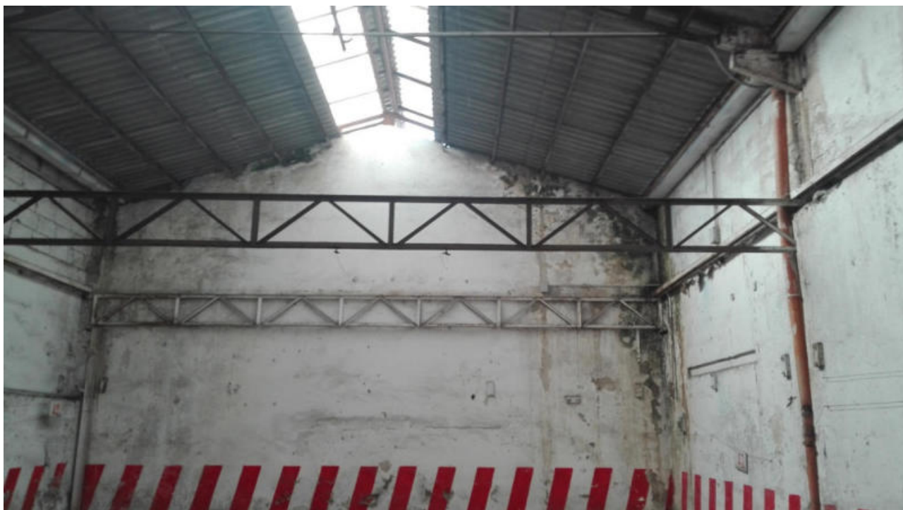
Foto n. 21. Vista interna del locale
