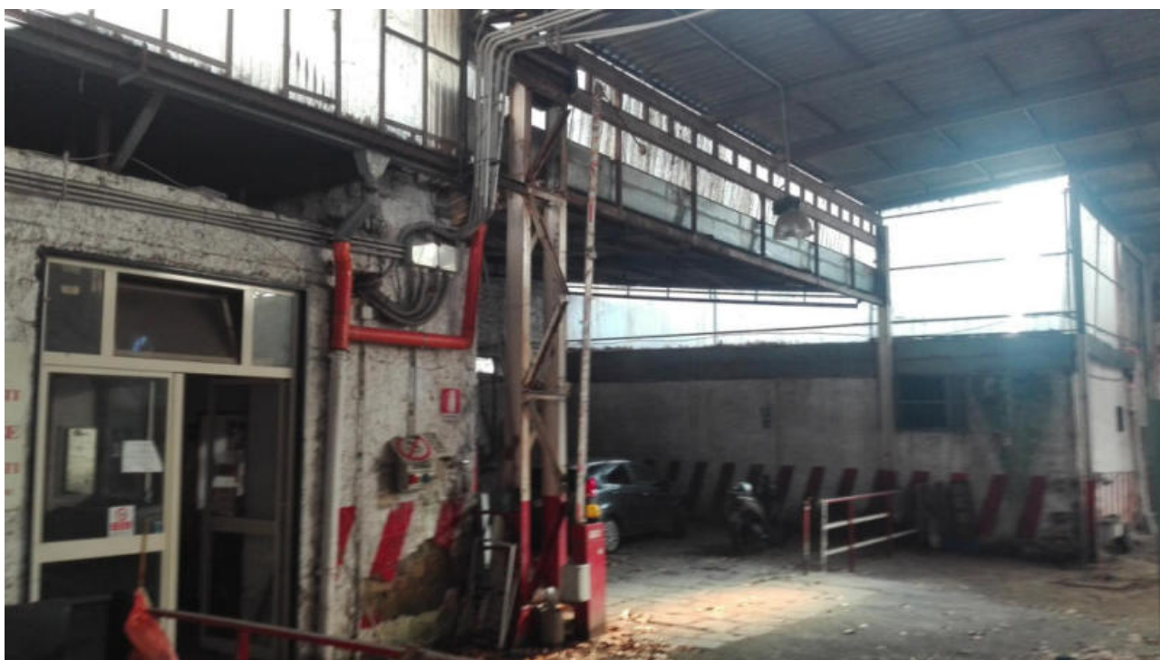
Foto n. 16. Vista della zona di ingresso al capannone di via Nicolini n. 47. Si distingue in primo piano a sinistra il vecchio corpo di fabbrica in muratura di tufo ad unico livello posto sul fronte strada di via Nicolini ed a destra l'area di ingresso al capannone prima scoperta e poi coperta con lamiera.
