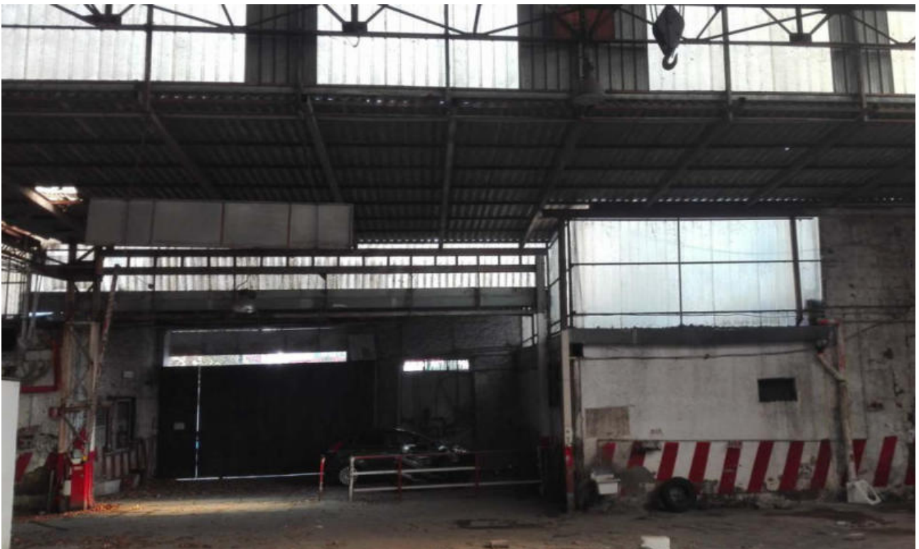
Foto n. 18. Vista della zona di ingresso al capannone di via Nicolini n. 47 si distingue l'area di accesso da via Nicolini. A sinistra il piccolo corpo di fabbrica in muratura, a destra il locale di altra proprietà con accesso diretto dall'esterno.
