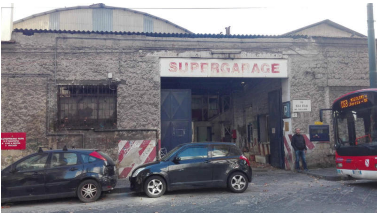
Foto n. 4. Via Nicola Nicolini, vista dell'ampio varco di accesso al locale. Sulla destra si distingue l'edificio in muratura con solaio subito dopo il varco di accesso coperto invece con tettoia.
