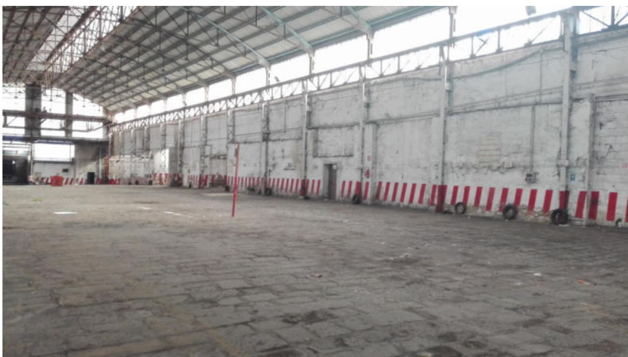
Foto n. 20. Vista interna del locale
