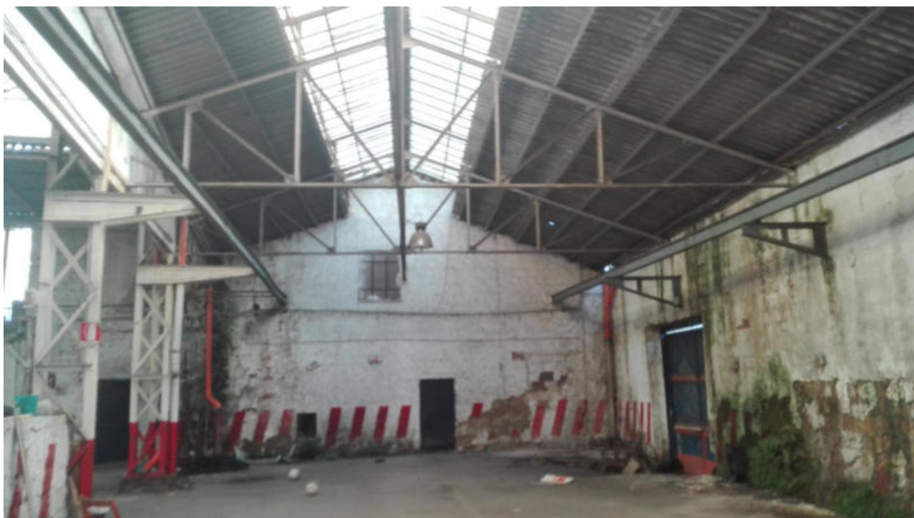
Foto n. 14. Vista interna del locale
