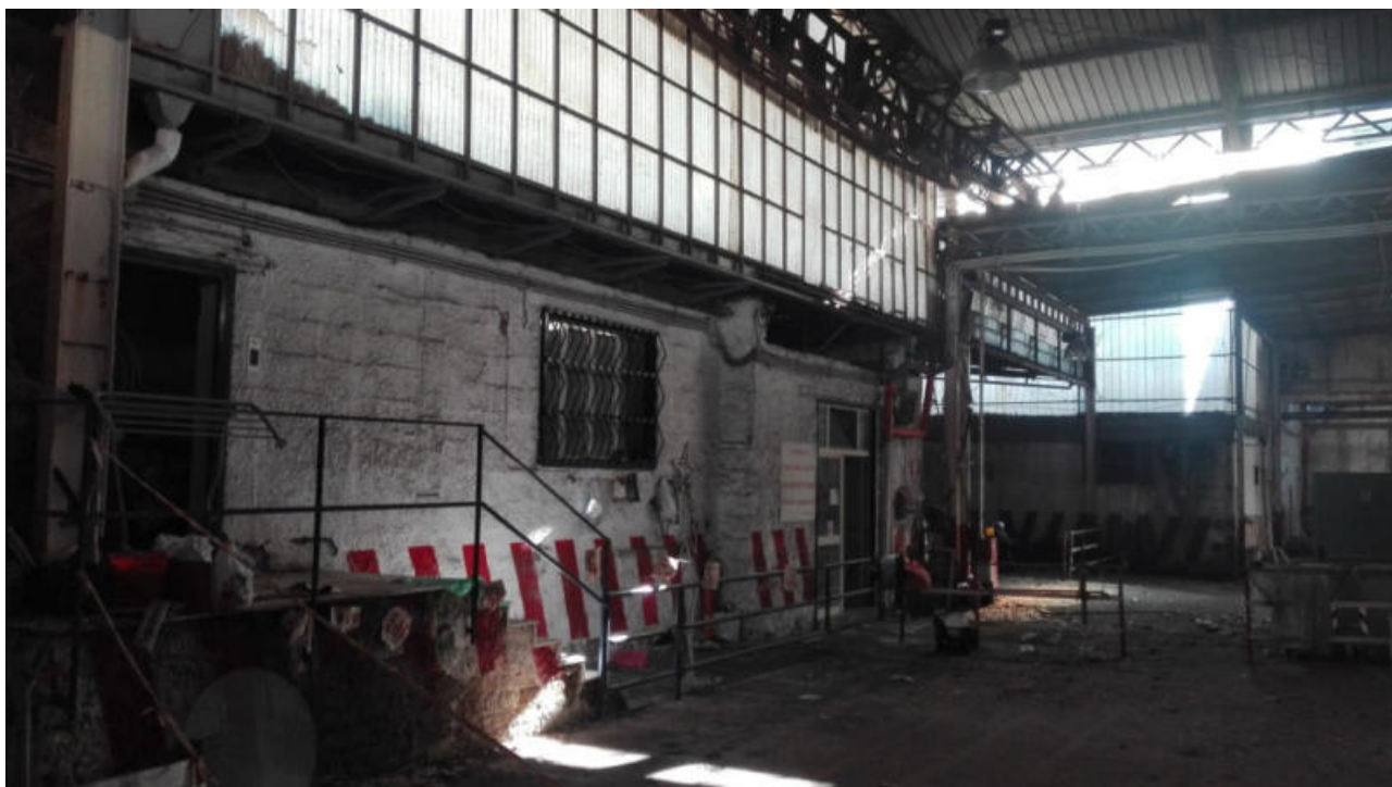
Foto n. 15. Vista della zona di ingresso al capannone di via Nicolini n. 47. Si distingue in primo piano a sinistra il vecchio corpo di fabbrica in muratura di tufo ad unico livello posto sul fronte strada di via Nicolini ed in fondo l'area di ingresso al capannone prima scoperta e poi coperta con lamiera.
