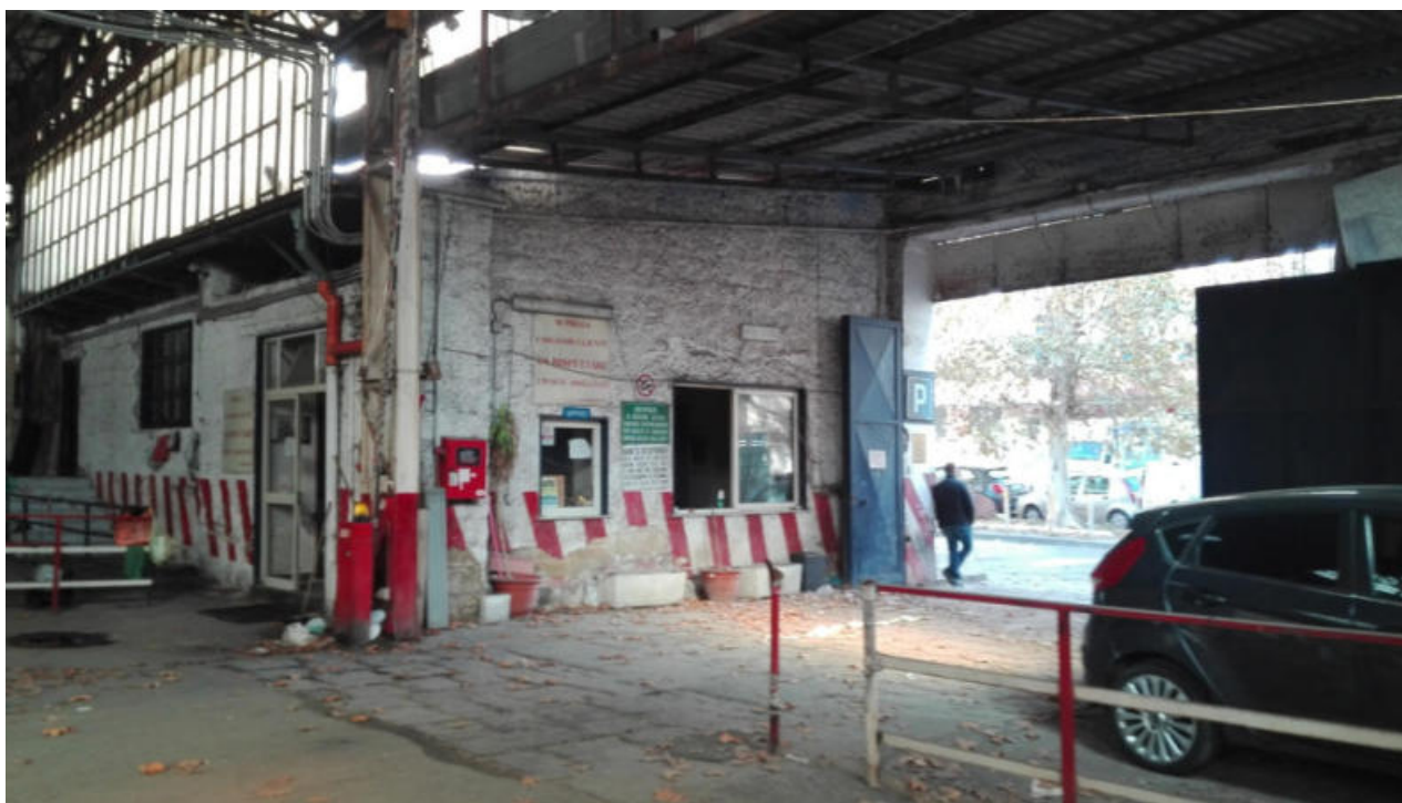
Foto n. 10. Varco d'ingresso al locale commerciale su via Nicolini. In primo piano i manufatti in muratura e l'area di ingresso coperta con tettoia
