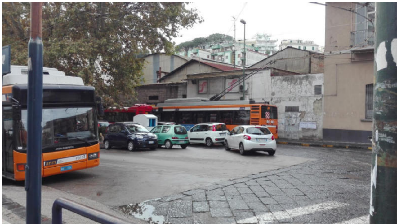
Foto n. 7. Vista del complesso dalla strada
