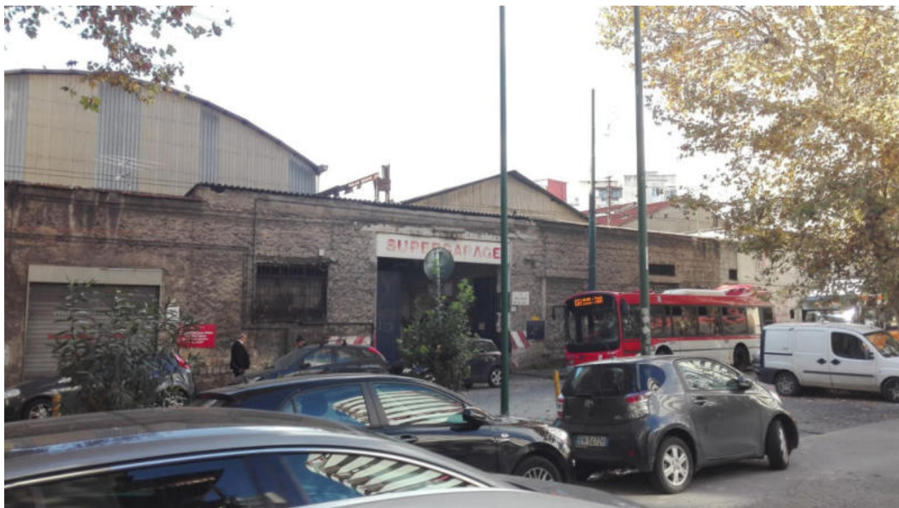
Foto n. 1. Via Nicola Nicolini, vista dell'immobile con i corpi in muratura fronte strada e capannoni sul retro
