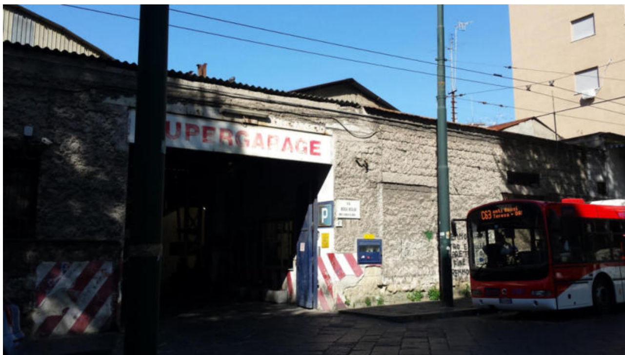
Foto n. 2. Via Nicola Nicolini, vista dell'ampio varco di accesso al locale.
