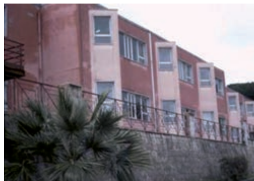
Il plesso di Via Campi Flegrei dell'I.C. Settimo Don Lorenzo Milani, sede della Scuola Secondaria Inferiore, è situato alle pendici del Vesuvio, nella zona agricola e residenziale di Torre del Greco. Lo stesso panorama che si gode dalle finestre della scuola, ha suggerito il soggetto della ricerca: Il Vesuvio e la città.
