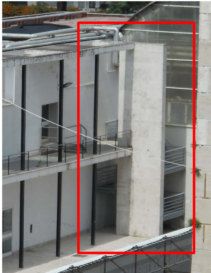
Figura 15 - Stato attuale: la scala esterna in ferro
