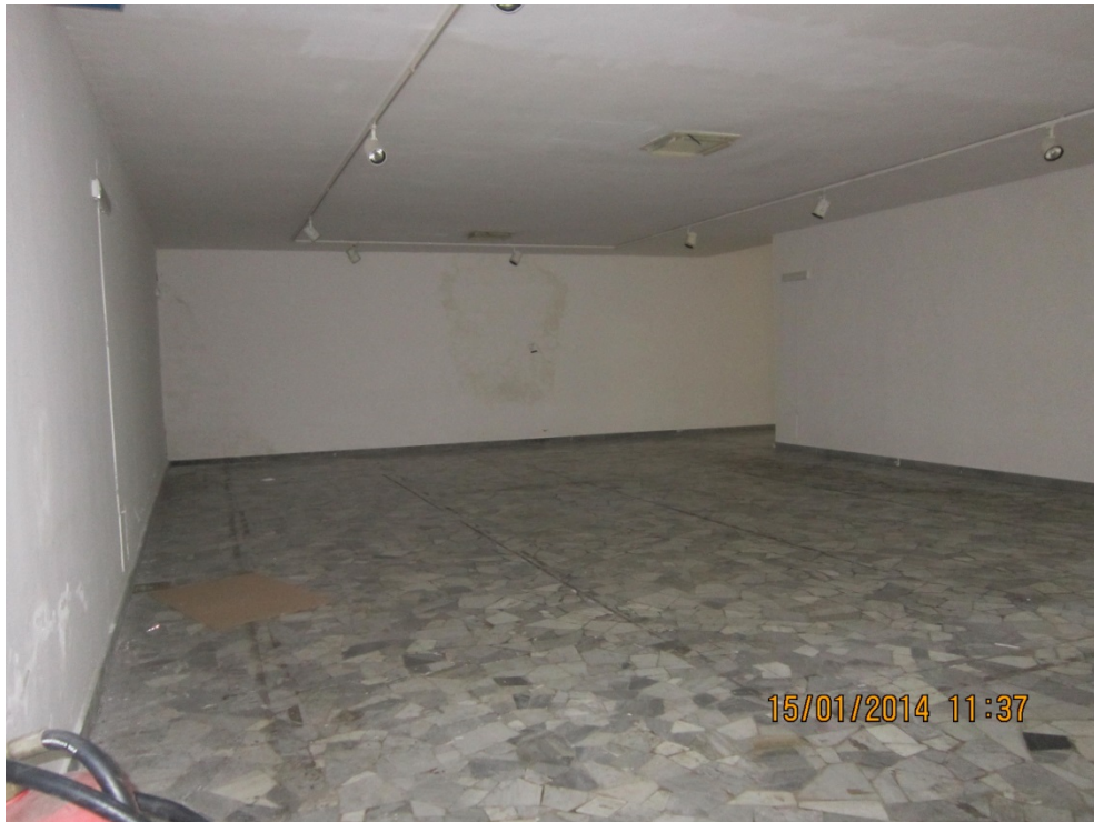
Figura 11 - Stato attuale: una delle sale con i vani murati (attuale pad. 9)
