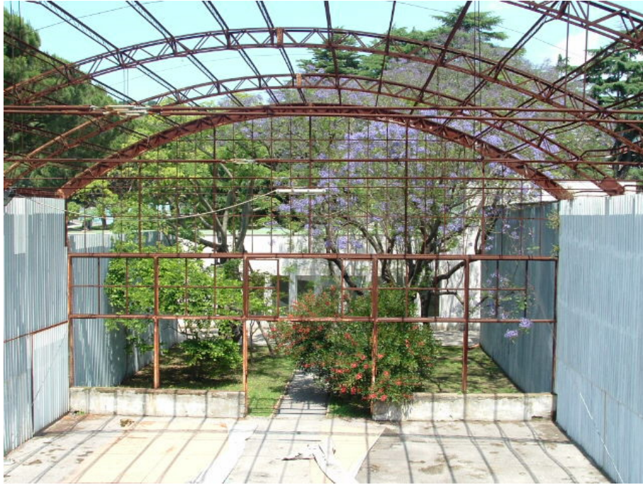
Figura 9 - Stato attuale: Il giardino interno (pavimentazione e copertura)
