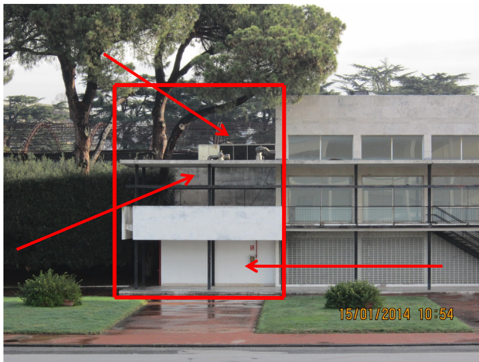
Figura 13 - Stato Attuale: I corpi aggiunti e gli impianti in copertura
