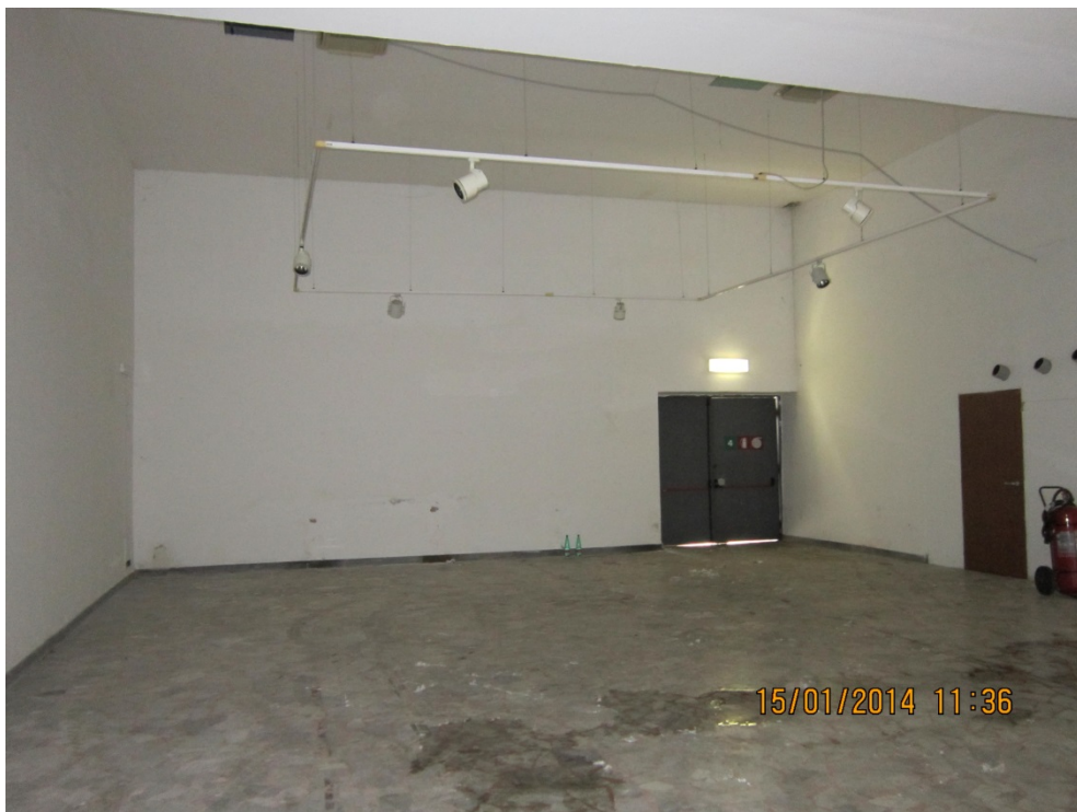
Figura 12 - Stato attuale: la grande vetrata tompagnata (attuale pad. 9)
