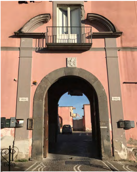
3. Portale di ingresso di Villa Amalia
