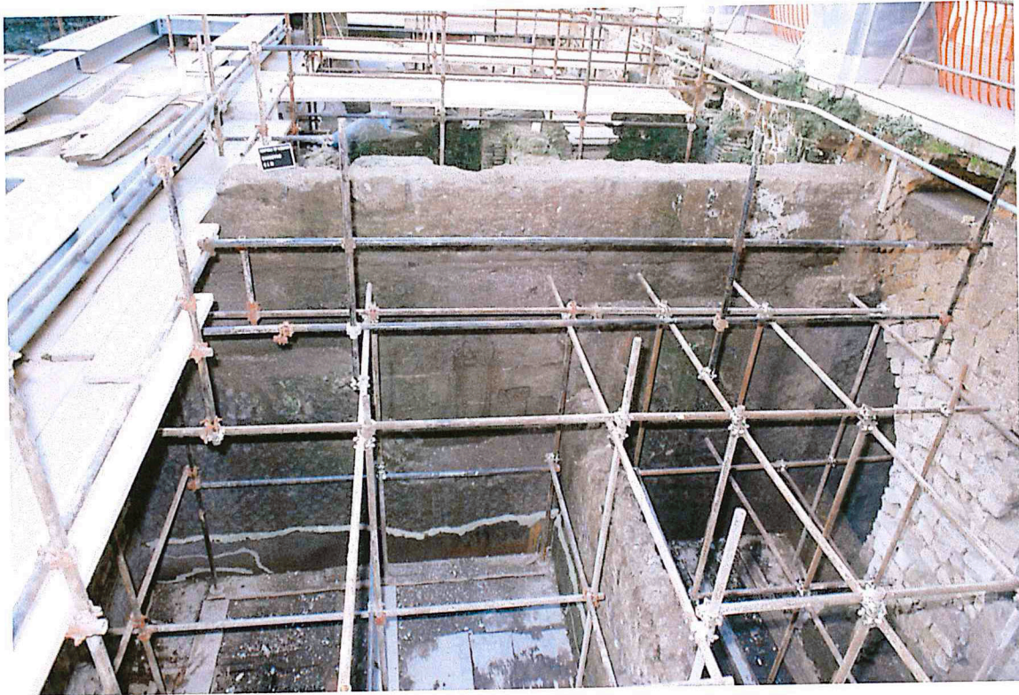
Settore occidentale: veduta generale precedente la realizzazione del solaio di copertura.
