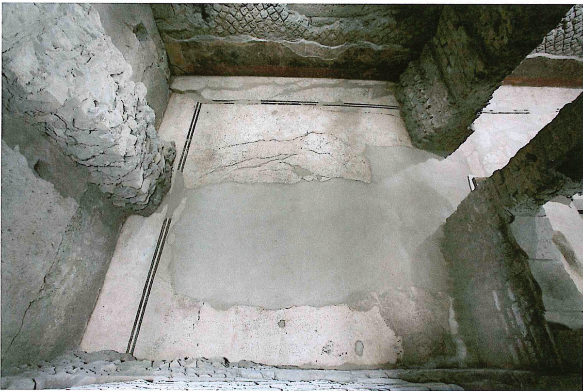
Settore occidentale - ambiente 49, lato a confine con l'ambiente 50 oggetto del nuovo intervento.
