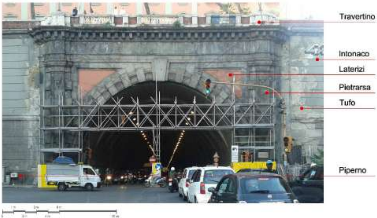
Prospetto su via Acton: materiali e tecniche costruttive
