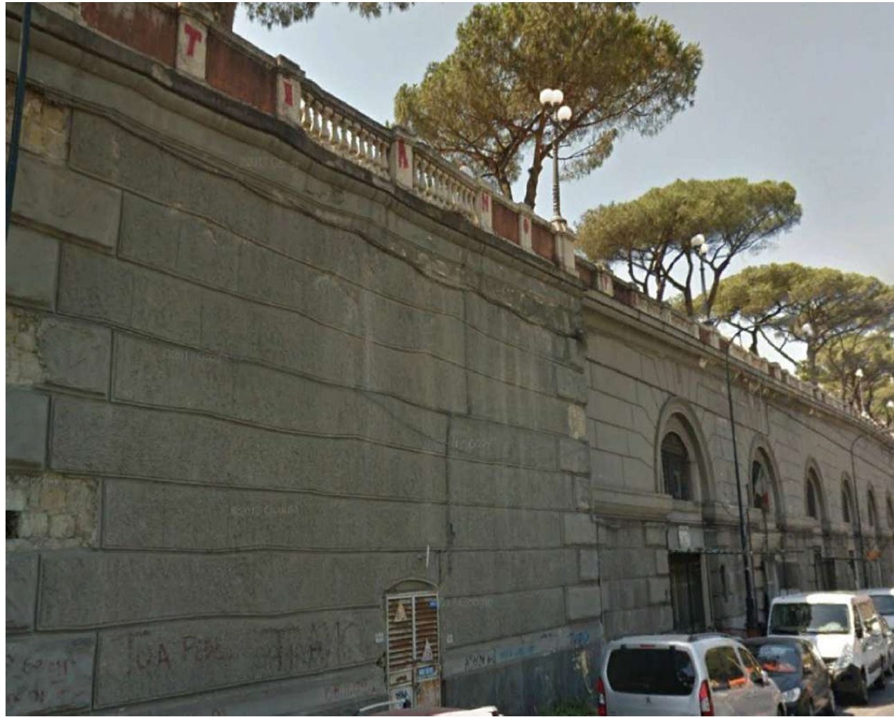
Foto 5 – Muro in adiacenza della facciata orientale (vista da sud)
