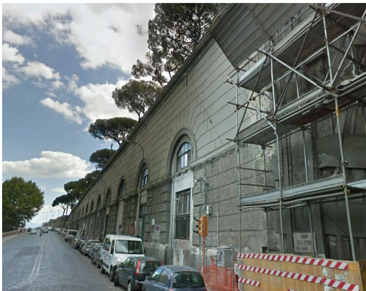
Foto 4 – Muro in adiacenza della facciata orientale (vista da nord)
