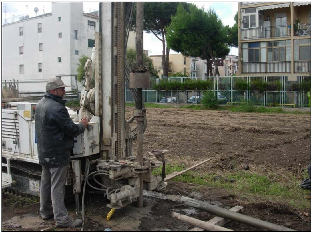
**FOTO N. 3 – Sondaggio n. 1 – Prova SPT**
