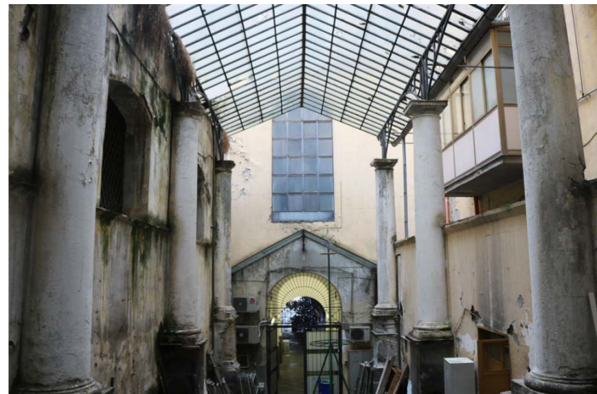
Figura 15 - La galleria del Gasse.
