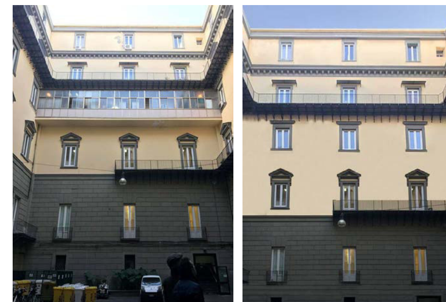
Figura 19– Ripristino della configurazione originale del prospetto ovest della corte A.
