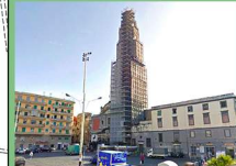
Lavori di restauro del campanile della chiesa del Carmine
