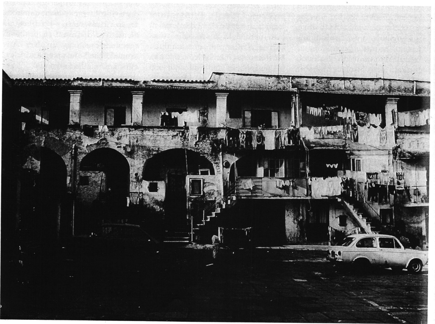
Prospetto interno di un edificio a corte in via Plebiscito a Piscinola.
