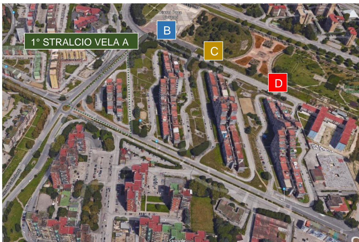
Vista aerea dell'intero lotto M con evidenziata l'area di 1° Stralcio della Vela "A"
