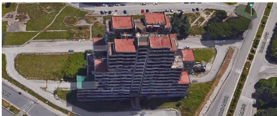
La Vela "A" da demolire
