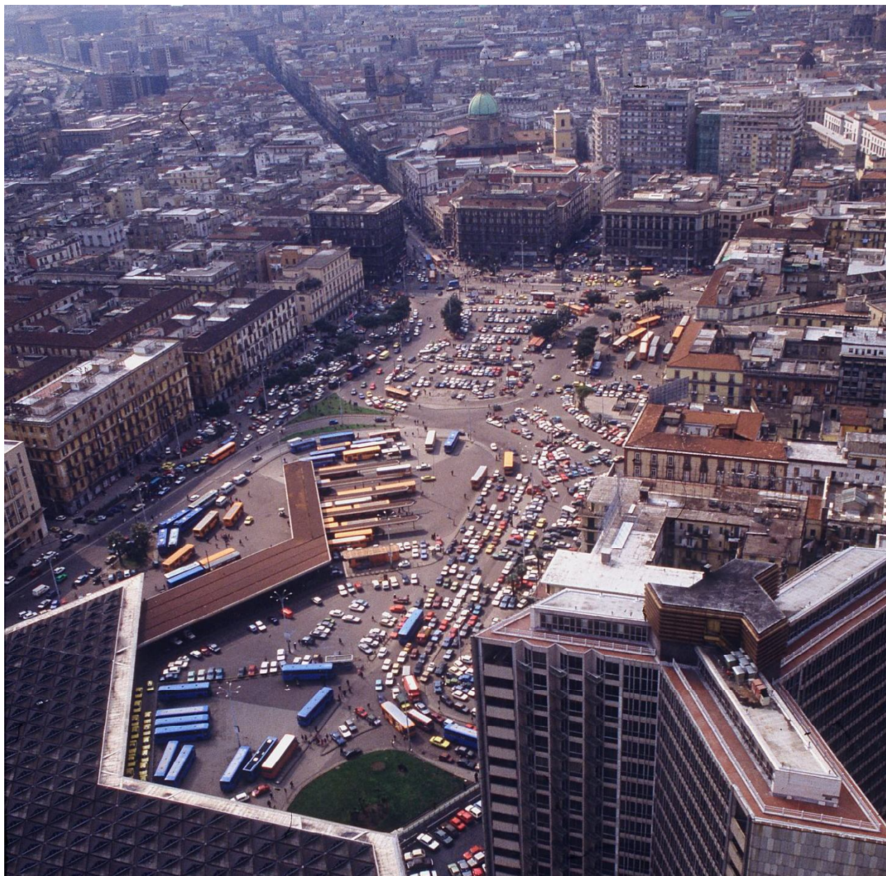
PIAZZA GARIBALDI PRIMA DELL'INTERVENTO (1998)
