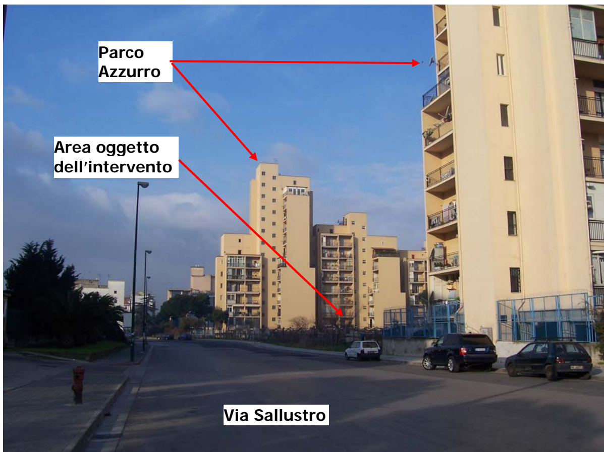
Foto n. 7 – Via Attila Sallustro: sulla destra in primo piano il “Parco Azzurro” seguito dall’area oggetto dell’opera da realizzare
