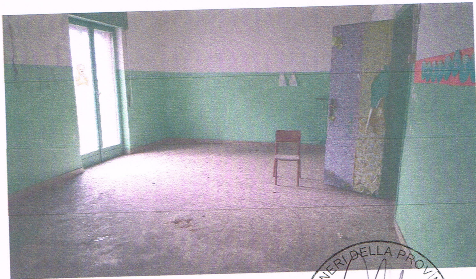
foto 17 (aula piano primo)
