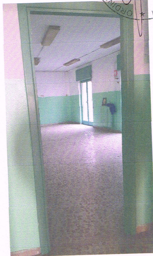
foto 8 (aula piano primo)
