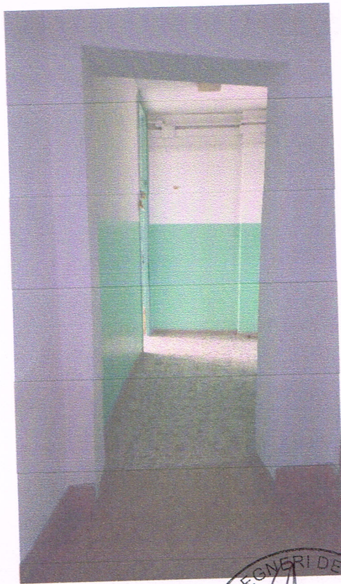
foto 5 (ingresso piano primo) ct. 19
