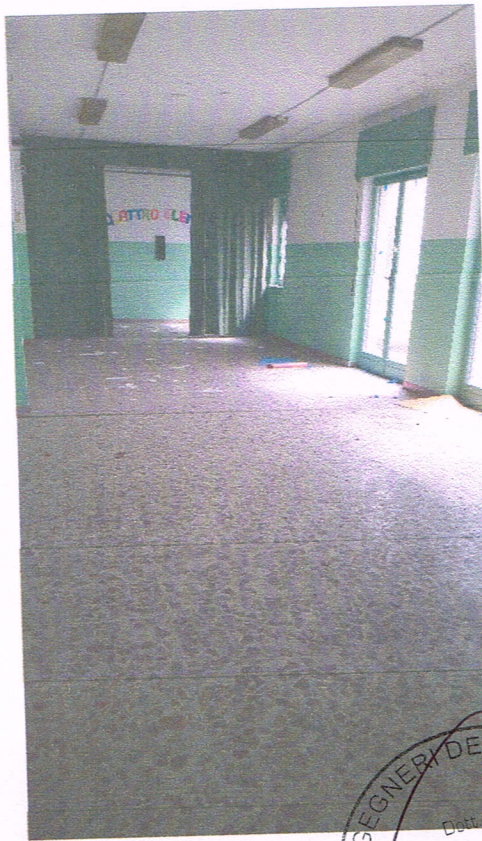
foto 19 (aula piano primo)
