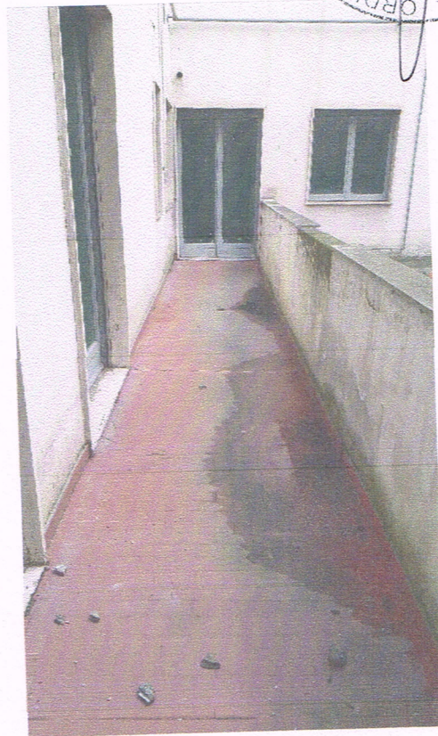
Foto 20 (balcone interno piano primo)
