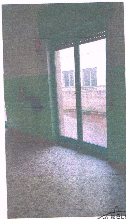
foto 9 (aula piano primo uscita su balcone)
