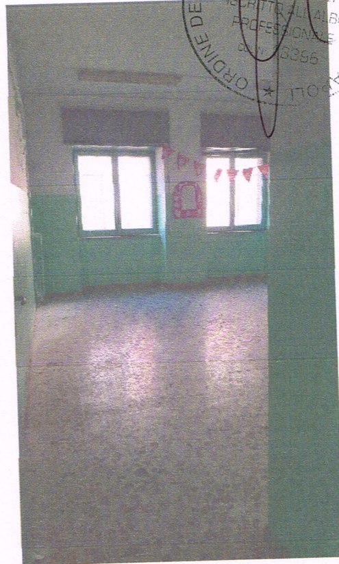
foto 6 (aula piano primo)
