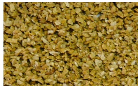
2. Completamento pavimentazione centrale del Ponte *carrabile( in inerti colorati (Giallo Mori) Tipo Rasocrete ; spessore 2/3cm.
