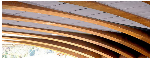
Struttura del Ponte in acciaio Corten. (Immagine del Ponte Parco Ausa - Rimini, con le arcate portanti in acciaio Corten)
