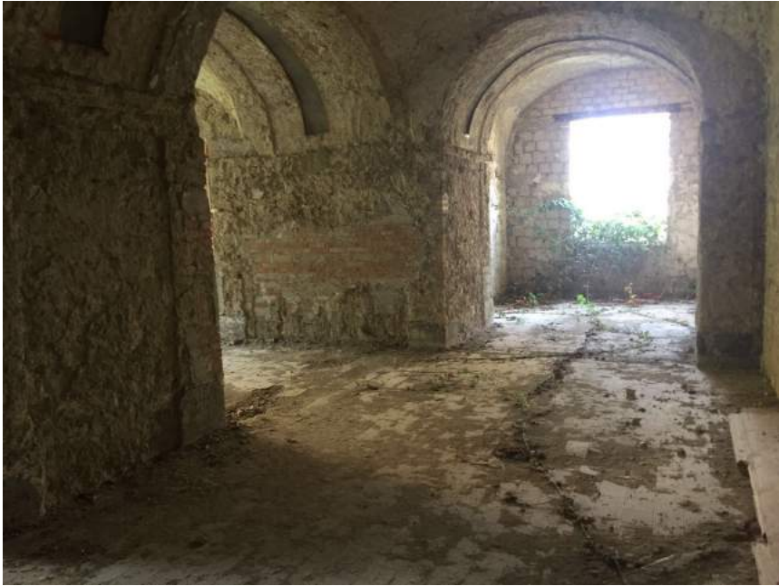
Foto Ingresso locali sotto la chiesa
