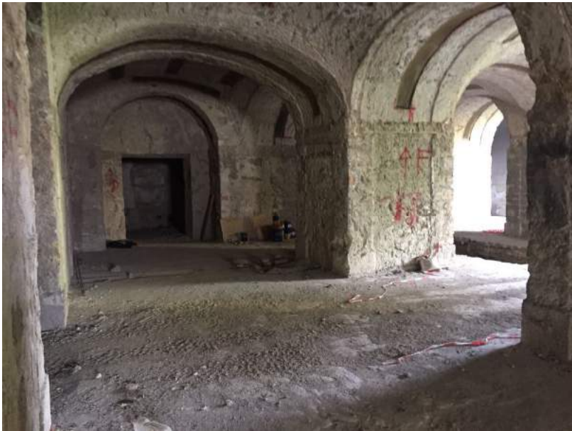
Foto Ingresso locali sotto la chiesa
