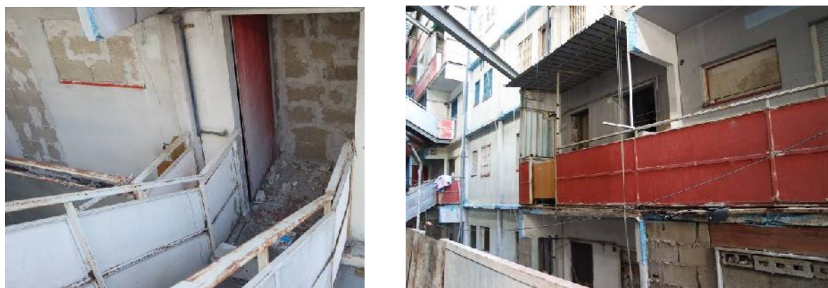
Figura 2: pannelli delle passerelle e delle scale in cemento amianto
