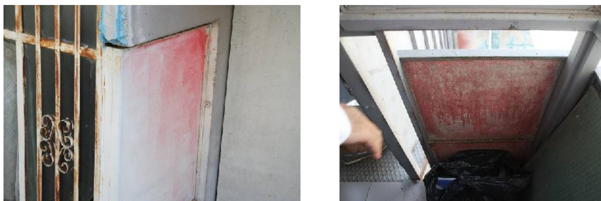
Figura 1: pannelli delle passerelle e delle scale in cemento amianto
